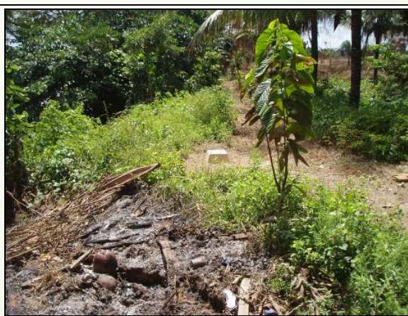
Foto 6.10 – Marcos de Referência para a estação Jusante do rio Beni instalada
