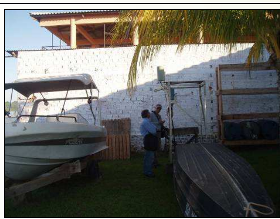
Foto 6.8- Estação telemétrica em Guajará-Mirim, no rio Mamoré
