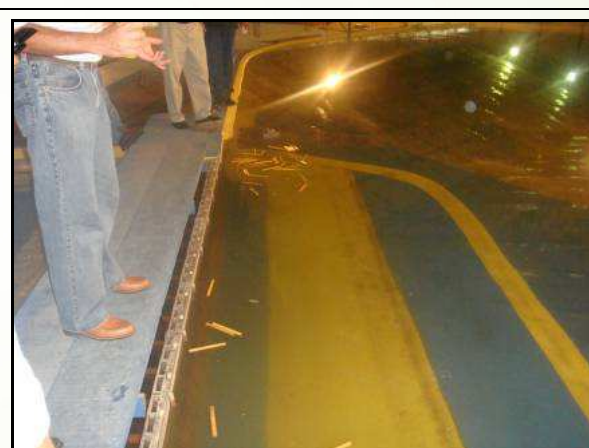
Foto 6.28 – Formação de vórtices na parte frontal da estrutura
