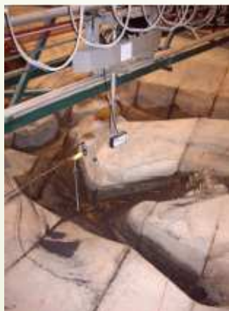
Foto 6.33 – Sistema de medição do sedimento depositado no leito
