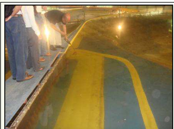
Foto 6.23 – Região frontal da tomada d'água/casa de força
