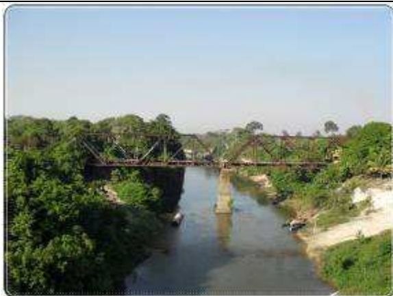
Foto 11: Ponte de Ferro da Estrada de Ferro Madeira Mamoré (EFMM)
