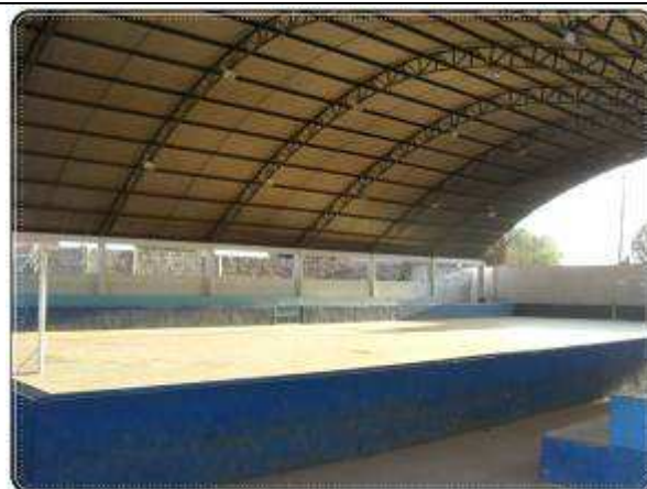
Foto 18: Quadra coberta EEEFM Maria de Nazaré dos Santos
