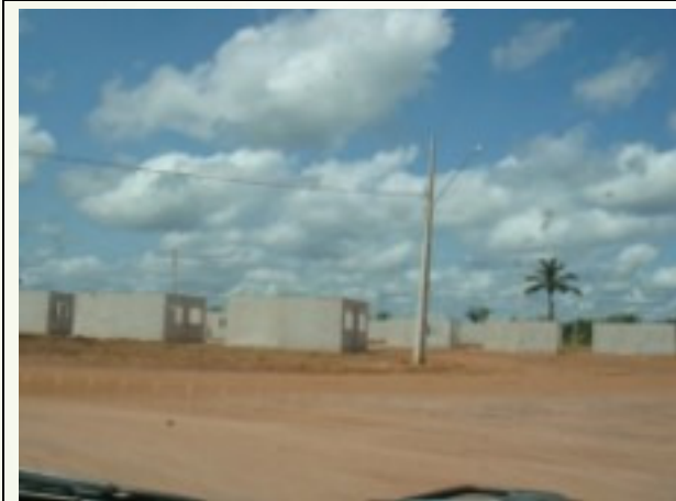
Processo de edificação das casas
