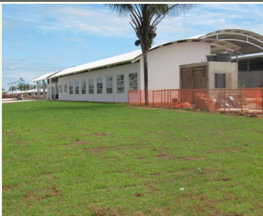
Escola de Ensino Fundamental no Polo – 07 salas (vista lateral)
