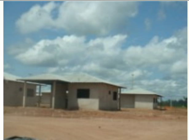
Processo de edificação das casas
