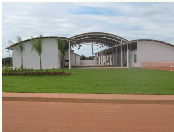
Escola de Fundamental no Polo – 12 salas (vista de trás)
