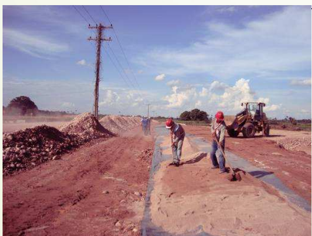
Foto 5 – Cobertura de 2a. camada
