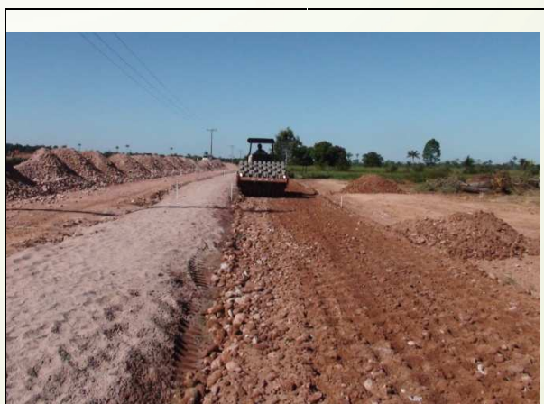
Foto 6 – Compactação com máquina leve
