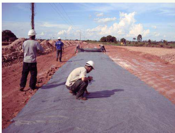
Foto 4 – Cobertura com manta geotêxtil
