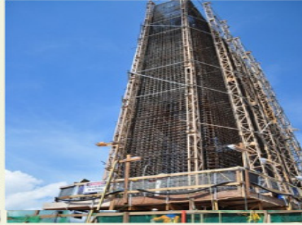
Concreto no primeiro pilar do Vertedouro
