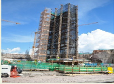
Concreto no primeiro pilar do Vertedouro
