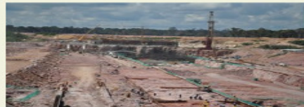
Concreto no primeiro pilar do Vertedouro
