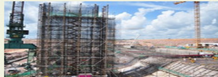
Concreto no primeiro pilar do Vertedouro
