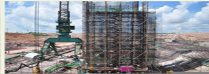
Concreto no primeiro pilar do Vertedouro
