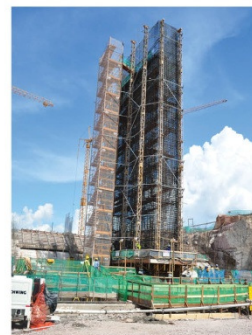
Primeiro pilar é concretado
