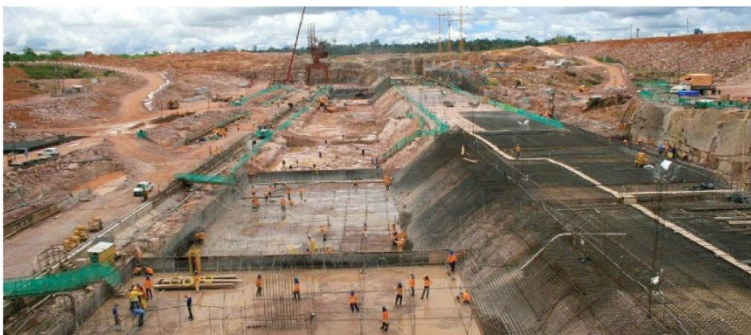
Concretagem do Vertedouro no canteiro de obras da Usina Jirau
