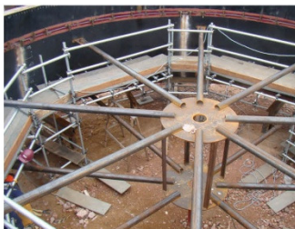
Pré-montagem das virolas na UHE Jirau
