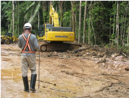
Acompanhamento das atividades de limpeza na margem esquerda.
