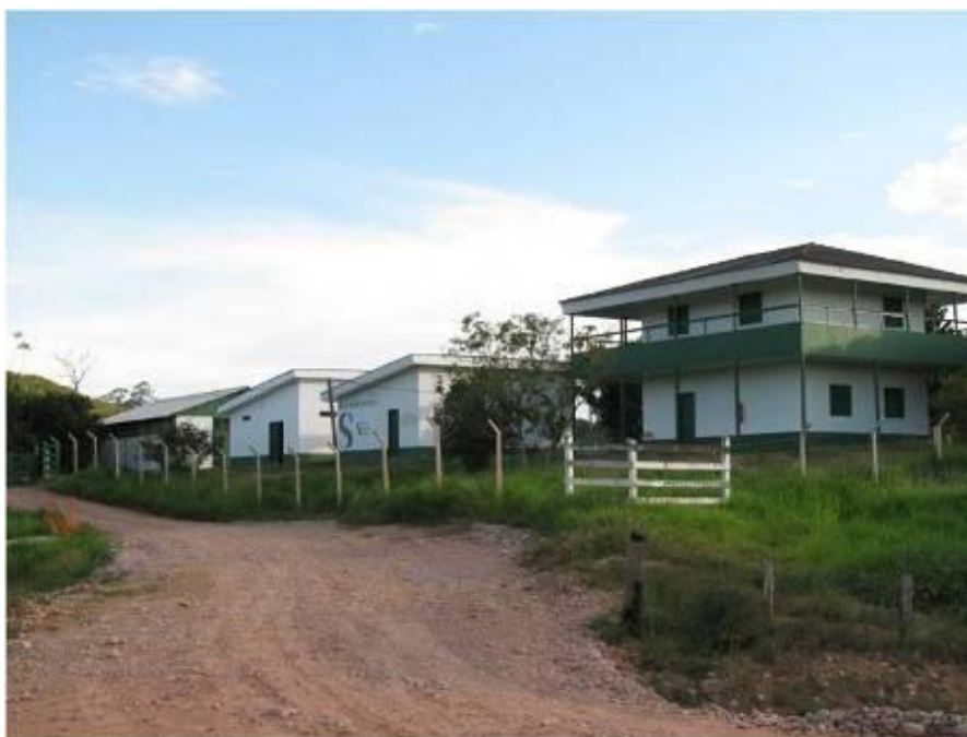
Figura 1. Vista geral da Base de Resgate Provisória.
