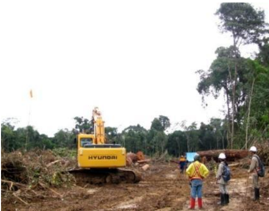
Acompanhamento das atividades de limpeza na margem direita.
