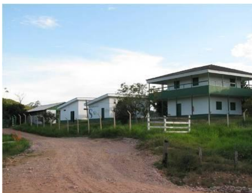
Figura 1. Vista geral da Base de Resgate Provisória.
