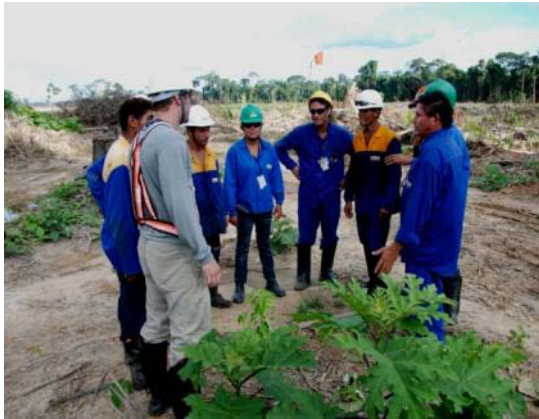
Orientação em relação à fauna silvestre aos trabalhadores da Tercon Construções e Terraplanagem durante o Diálogo Diário de Segurança (DDS) na margem direita.
