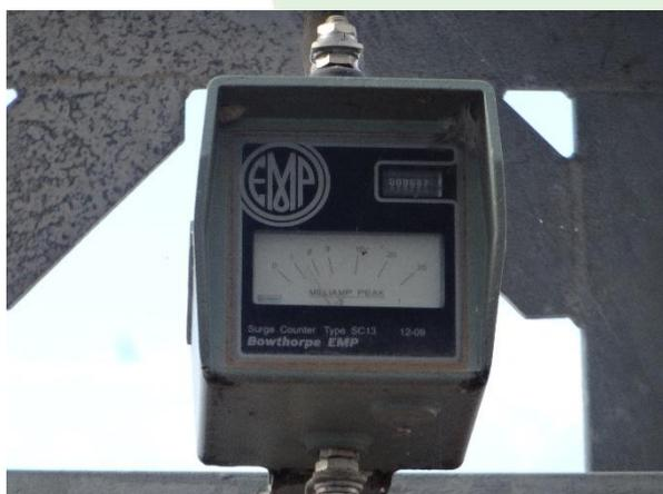
**Foto 9-1** – Contador de descargas atmosféricas. Este equipamento registra a quantidade de descargas atmosféricas no trecho de 95km das linhas de transmissão da UHE Jirau.
