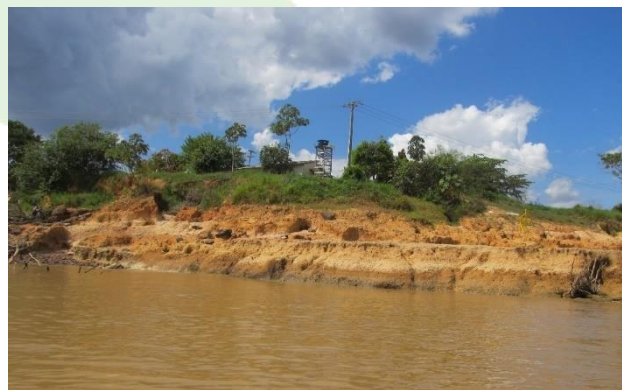
Foto 5-8 – Foto mostrando a erosão fluvial, no ponto JMD-03.
