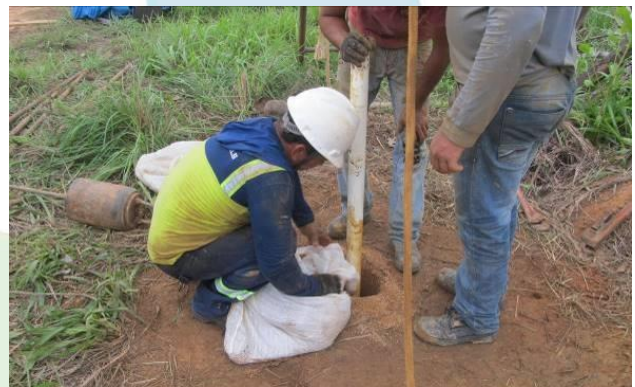
Foto 4-6 – Procedimento de preenchimento com pré-filtro (cascalho).
