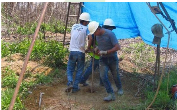
Foto 4-5 – Detalhe da sondagem a trado para instalação de poço de monitoramento.
