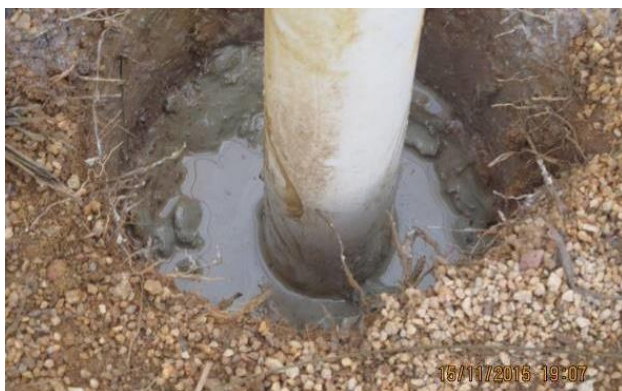
Foto 4-7 – Procedimento de preenchimento com selo de bentonita.
