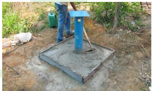
Foto 4-8 – Detalhe da construção do acabamento final do poço.
