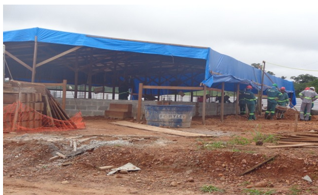
Foto 7-1 – Construção da agroindústria de açaí – 02/03/16
