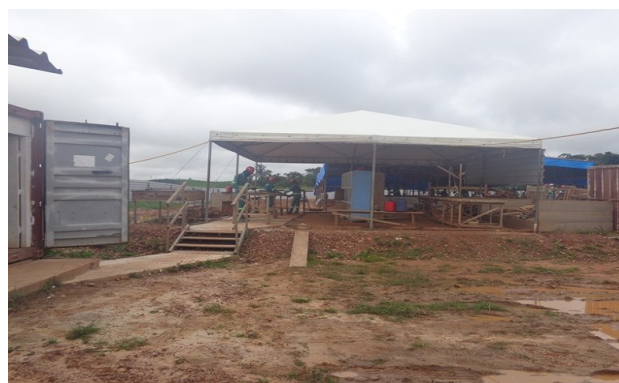
Foto 7-2 – Construção da agroindústria de açaí – 02/03/16
