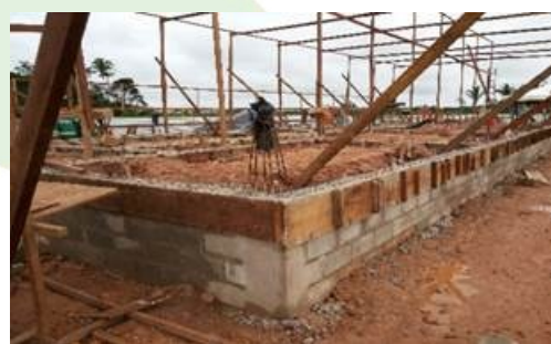
Foto 7-6 – Visita à construção da agroindústria de açaí
