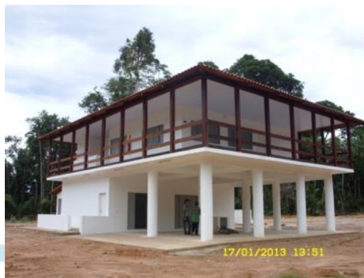
Foto 5-7 – Posto de Vigilância – TI Igarapé Ribeirão Data: Janeiro/2013
