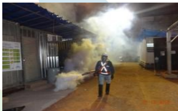
Foto 3-28 – Termonebulização espacial no canteiro de obras
