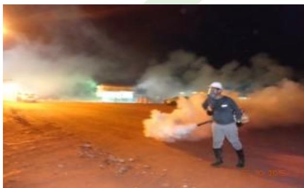
Foto 3-27 – Termonebulização espacial no canteiro de obras
