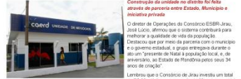
Construção da unidade no distrito foi feita através de parceria entre Estado, Município e Iniciativa privada. O diretor de Operações do Consórcio ESBR Jacy, José Lúcio, afirmou que o sistema contribuirá para melhorar a qualidade de vida da população. Destacou que por meio da parceria com o município e o governo estadual, o grupo entregará durante o ano um benefício de água à população local, e de aniversário, ao Estado de Rondônia pelos seus 34 anos de criação. Lembra que o Consórcio de Jacy investiu um total de R$ 20 milhões na construção de 36 projetos sociais em parceria com o município de Porto Velho, incluindo o projeto de construção de escolas, tratamento de 4 km de rio e uma campanha permanente de combate à prostituição infantil e redução dos indicadores da violência na região. Participaram ainda da inauguração do sistema e entrega de duas retroscavadeiras, a assessora técnica Marcia Aurino, o diretor técnico operacional da Caerd, Mauro Sestini, os vereadores Jander Bergale e Carlos Albert, além de outros representantes militares e civis locais e imprensa.
