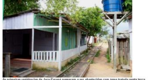
As primeiras residências de Jaci-Paraná passam a ser abastecidas com água tratada nesta terça (22), após inauguração da unidade de tratamento do distrito
