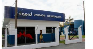
As primeiras 500 residências dos bairros Nova e Velha Jaci, Fátima Espinosa e Alto Alegre, além central do distrito de Jaci-Paraná, em Porto Velho, começaram a ser abastecidas na manhã desta terça-feira (22) com água tratada distribuída pela Companhia de Água e Esgoto de Rondônia (Caerd)
