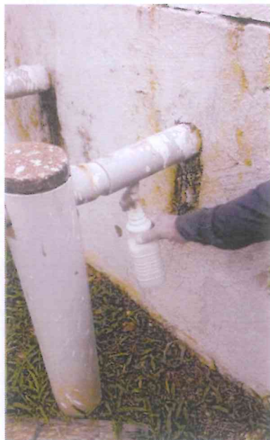
Figura 3-1 – ETE "C" efluente tratado.
