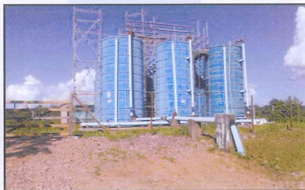
Figura 2-4 - Castelinho de apoio.
