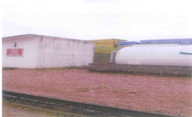
Figura 2-7 - Vista ETE GDA e casa de máquinas.
