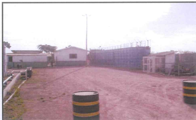
Figura 2-2 - Vista geral do pátio e equipamento.
