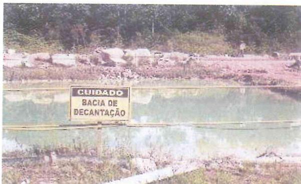
**Foto 2-82** – Bacia de decantação na central de concreto.
