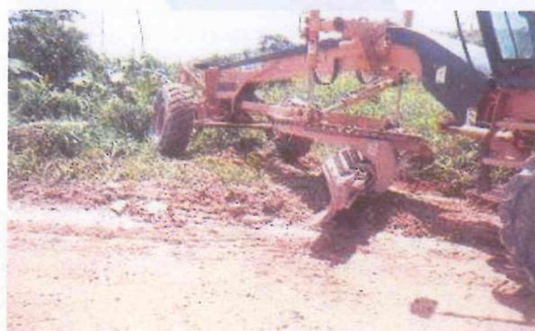
**Foto 2-18** – Execução de direcionamento de águas pluviais.
