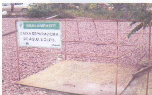
**Foto 2-34** – Sistema de separação de água e óleo.
