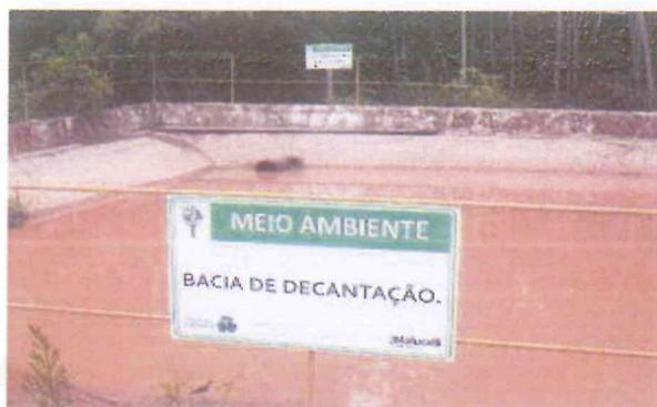
**Foto 2-36** – Bacia de decantação de sedimentos na rampa de lavagem.
