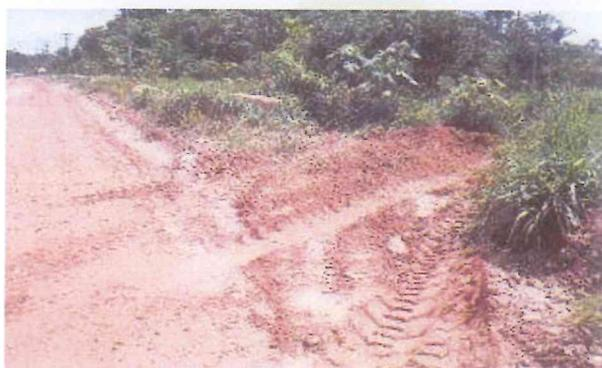
**Foto 2-17** – Direcionamento das águas superficiais nas vias.
