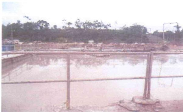
**Foto 2-35** – Lagoa de sedimentação da central de concreto.
