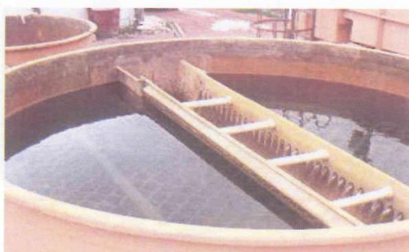
**Foto 2-28** – Sistema de decantação na E.T.A.
