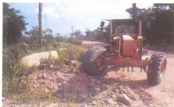
**Foto 2-77** – Direcionamento de águas pluviais nas vias.
