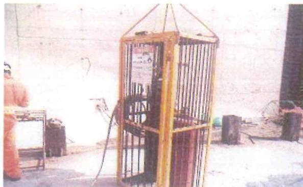
**Foto 2-67** – Gaiola de armazenamento de cilindro de gás comprimido.
