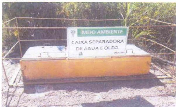
**Foto 2-64** – Caixa separadora localizada no plant de combustível.
