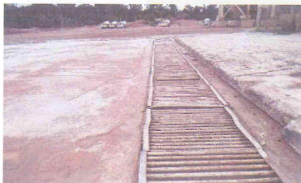
**Foto 2-70 – Sistema de drenagem de efluente.**
