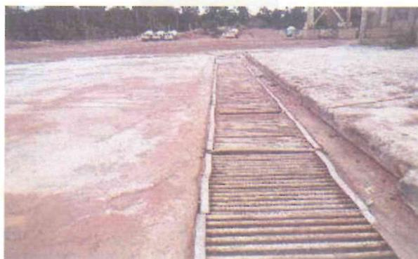
**Foto 2-2** – Vista do sistema de drenagem de efluentes.
