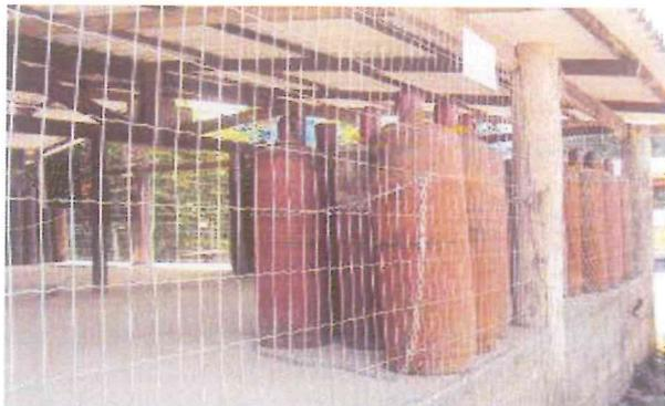
**Foto 2-66** – Baía de armazenamento de cilindro de gás comprimido.
