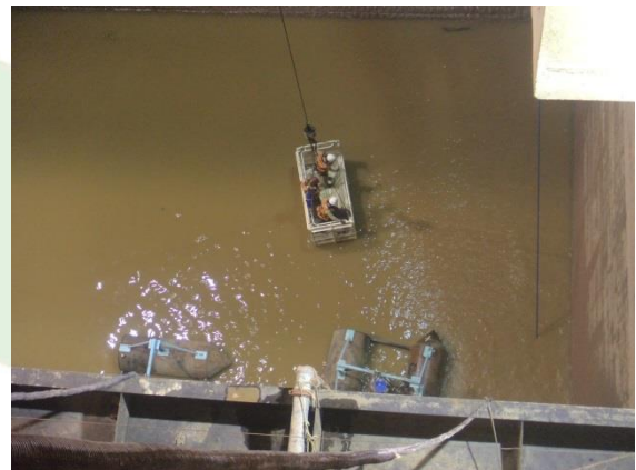
Foto 3-2 - Transporte de profissionais com utilização de gaiola, durante atividades no vertedouro.
