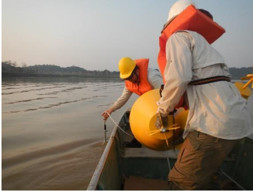
Foto 2-3 - Instalação dos equipamentos de telemetria acústica no Programa de Conservação da Ictiofauna da UHE Jirau
