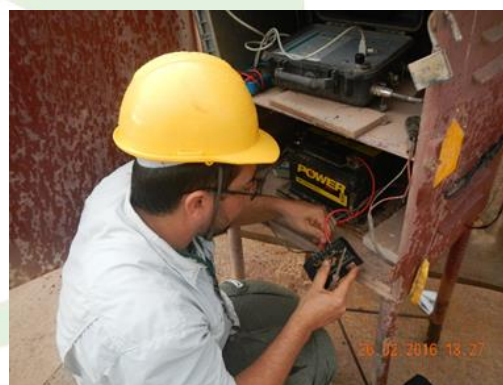
Foto 2-2 – Manutenção do sistema de alimentação de uma base fixa de radiotelemetria instalada a jusante do vertedouro da UHE Jirau
