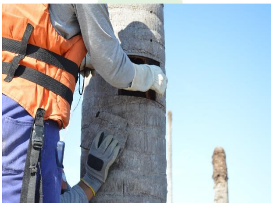
Figura 13. Fechamento da abertura.
