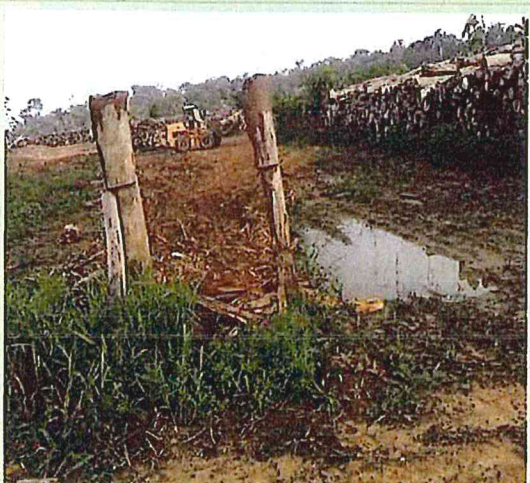
Foto 21: Relocação de pilhas de madeira – P1C02-MD.
