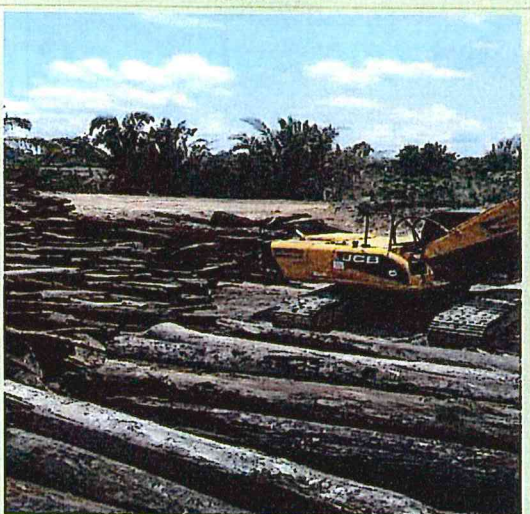
Foto 23: Empilhamento do material relocado internamente – P1A02-MD.
