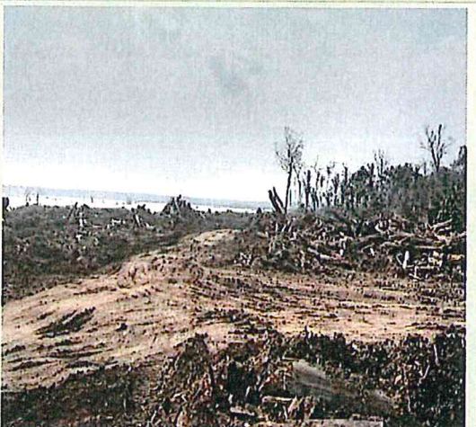
Foto 29: Relocação de pilhas de madeira – P5C5D01-ME.
