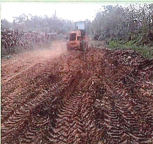
Foto 22: Relocação de pilhas de madeira – P1C02-MD.
