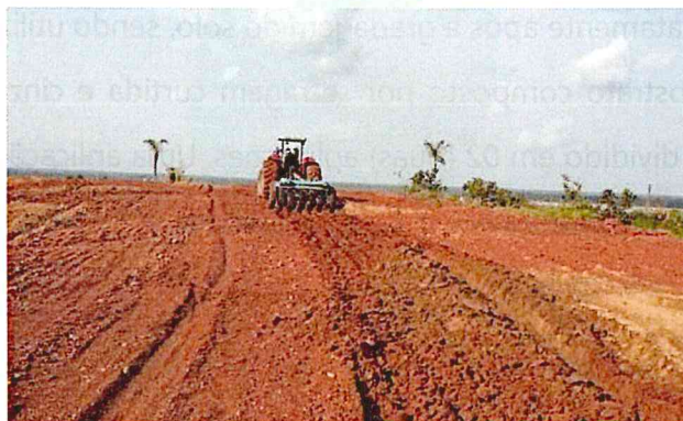
Foto 4-5 – Gradagem/descompactação do solo.
