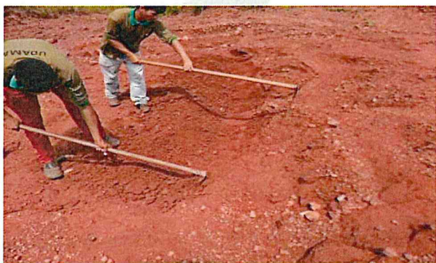
Foto 4-11 – Identificação e contenção de processos erosivos.
