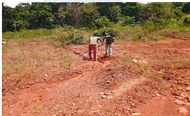
Foto 4-12 – Identificação e contenção de processos erosivos.
