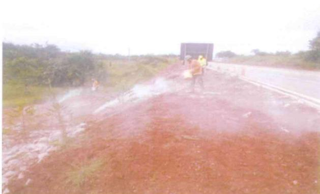
**Foto 5-20** - Talude sendo calcareado (área 21 MD).
