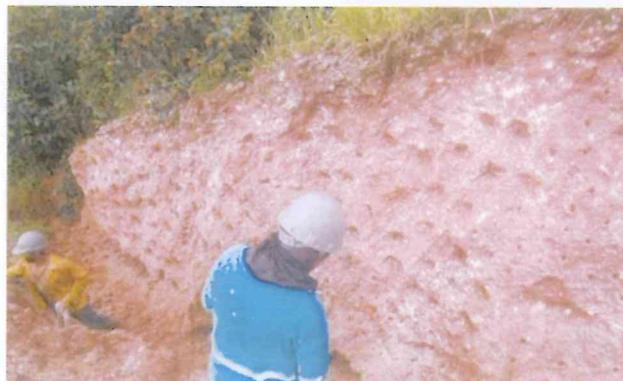
**Foto 5-22** - Talude com coveamento (área 02 MD).
