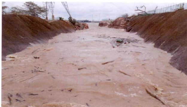
Foto 1 – Níveis d'água no STP escavado.
