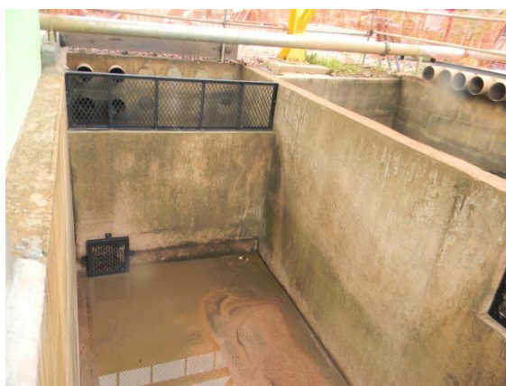
Figura 4.4.7. Substituição das telas de escoamento do tanque de abastecimento do STP-1.
