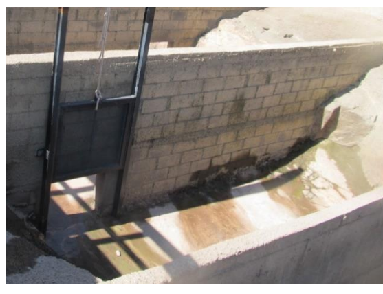
Figura 4.4.8. Regularização do fundo do canal de ascensão com a aplicação de concreto.
