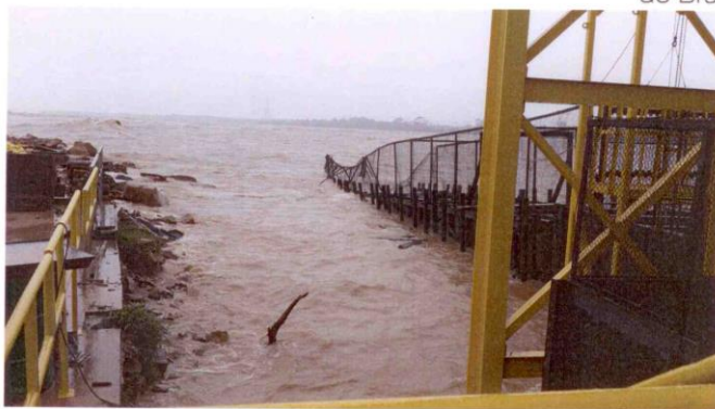
Foto 2 – Níveis d'água no STP metálico.
