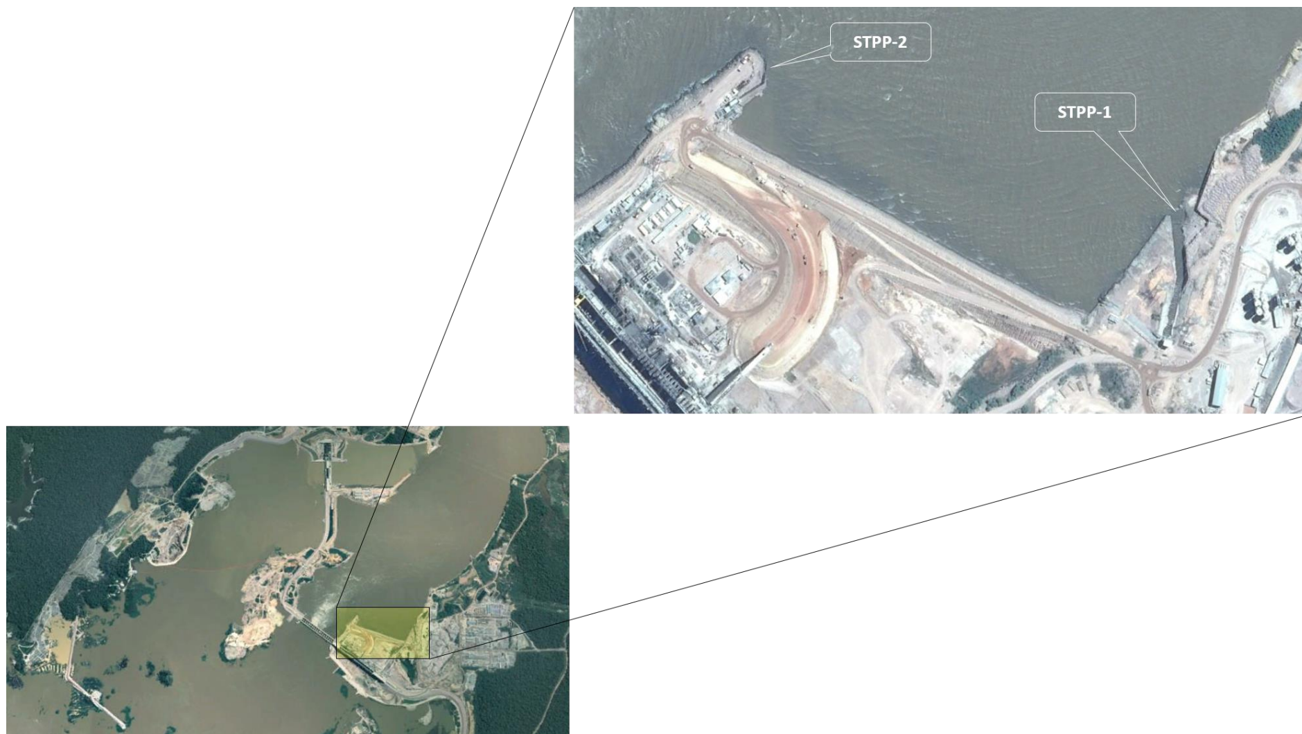
Figura 4.4.1. Situação locacional dos 02 (dois) Sistemas de Transposição de Peixes da UHE Jirau.
