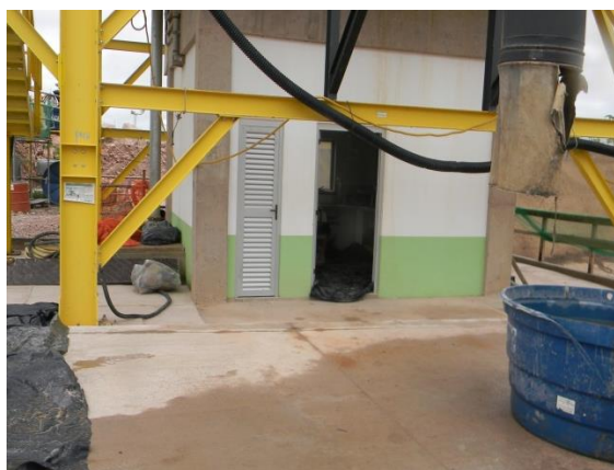
Figura 4.4.3. Construção do laboratório de triagem do STP-1.
