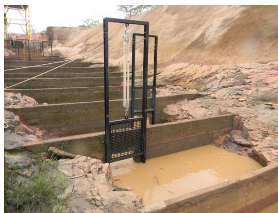
Figura 4.4.6. Montagem de grades para permitir a segmentação do STP, assim como o confinamento dos peixes em cada segmento.
