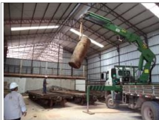
Foto 6– Descarga no Galpão de Nova Mutum Paraná
