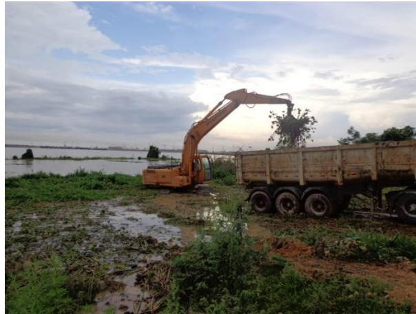
Figura 1. Retirada de macrófitas aquáticas na margem direita do barramento, próxima ao ponto P18-MAD5.
