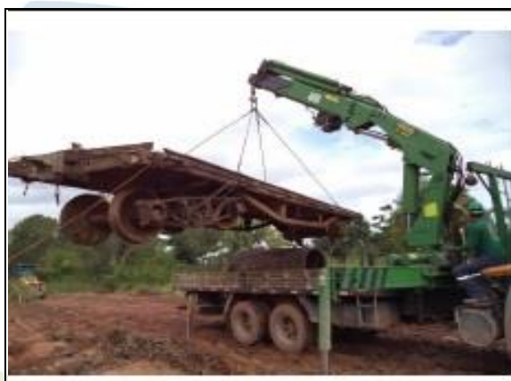
Foto 2 – Remoção dos remanescentes da EFMM (vagões).
