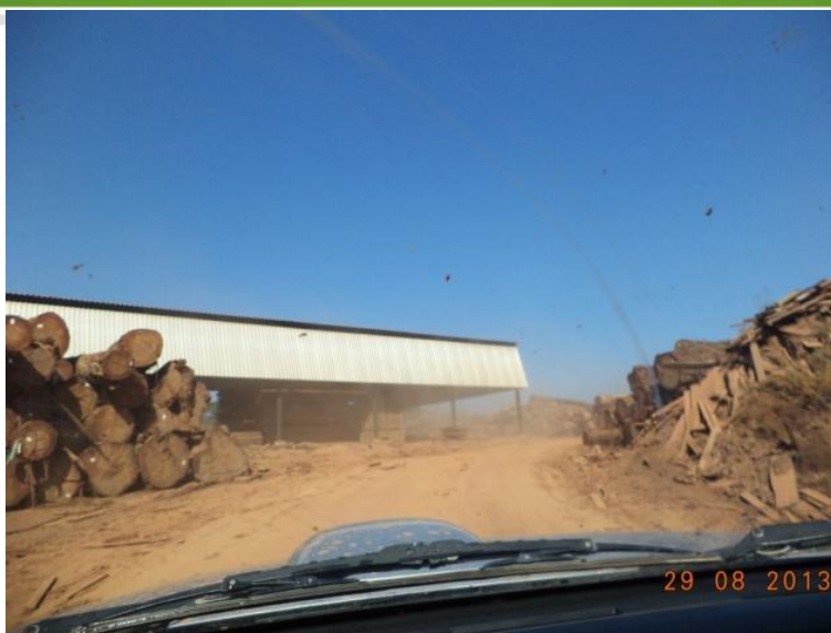
Figuras 6- Depósito de madeira e galpão construído na área expandida da madeireira, na APP do reservatório da UHE Jirau.
