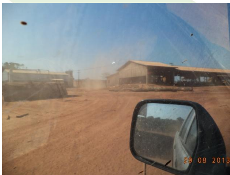
Figuras 5- Galpões construídos na área de expansão das madeireiras na APP do reservatório da UHE Jirau.
