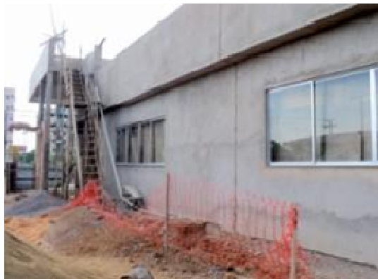
Foto 4.22.5 - Construção do Centro de Imagens do HB (Out12)
