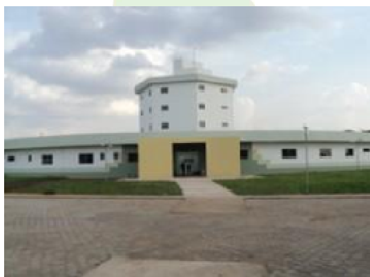
Foto 4.22.7 - Construção da Policlínica Oswaldo Cruz (Out12)
