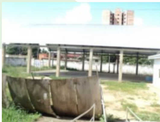
Foto 4.27.6 – Construção do CICA
