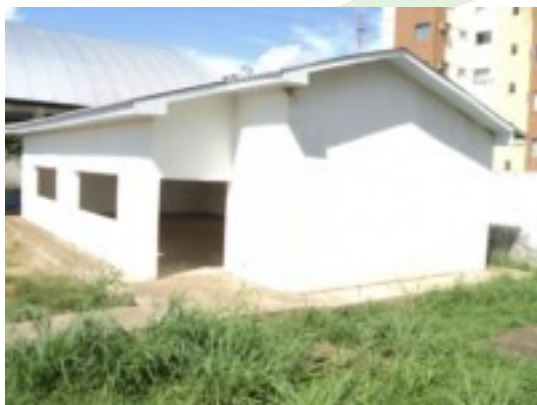
Foto 4.27.23 – Construção do CICA
