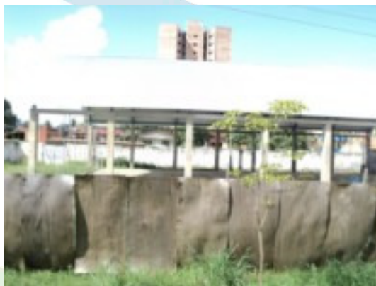
Foto 4.27.4 – Construção do CICA
