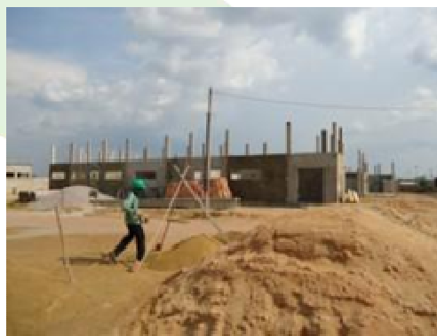
Foto 4.22.4 - Construção da UPA em Jaci-Paraná (Out12)
