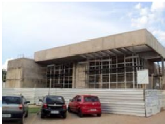
Foto 4.22.6 - Construção do Centro de Imagens do HB (Out12)
