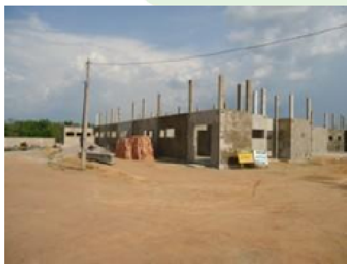
Foto 4.22.3 - Construção da UPA em Jaci-Paraná (Out12)
