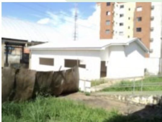
Foto 4.27.5 – Construção do CICA
