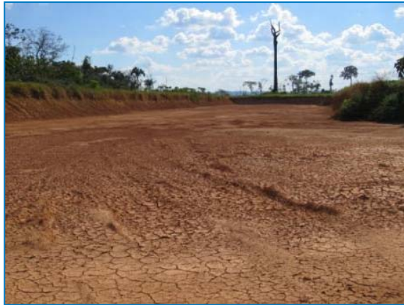
Figura 4-5 - Área de empréstimo com solo compactado.
