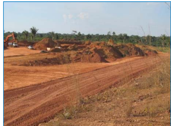
Figura 4-8 - Área de empréstimo em funcionamento na Macrorregião de Monitoramento 02.
