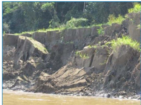
Figura 4-2 - Colapso de solo na margem esquerda do rio Madeira com predominância de argila-siltosa.
