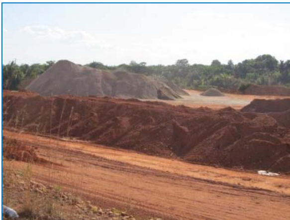
Figura 4-7 - Área de empréstimo em funcionamento contida na Macrorregião de Monitoramento 02.
