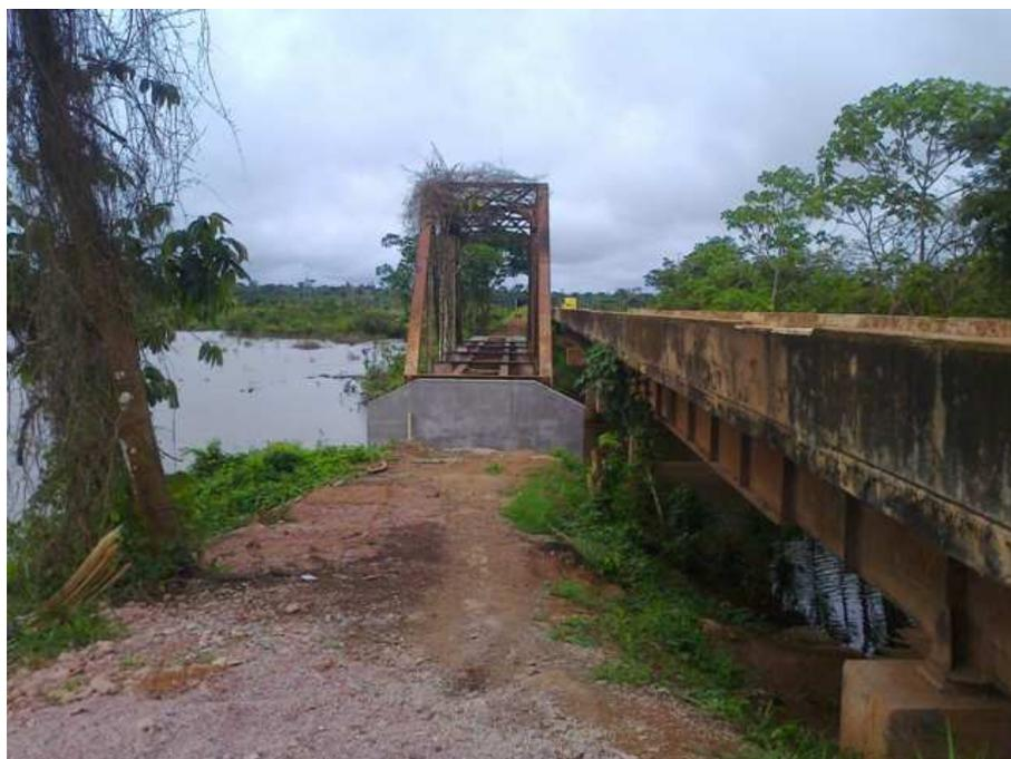
Foto 04 – Ponte Ferroviária sobre o Igarapé 162, após as obras de alteamento.
