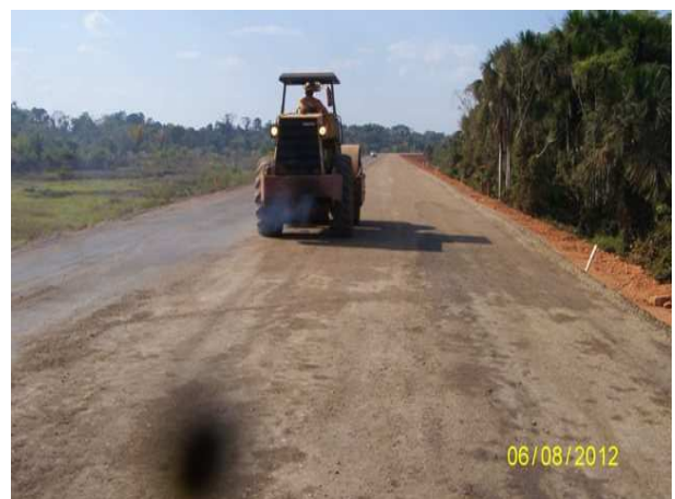
Foto 3.12 – Compactação de B.G.S.
