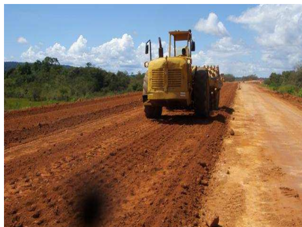
Foto 3.4 – Compactação do material de aterro
