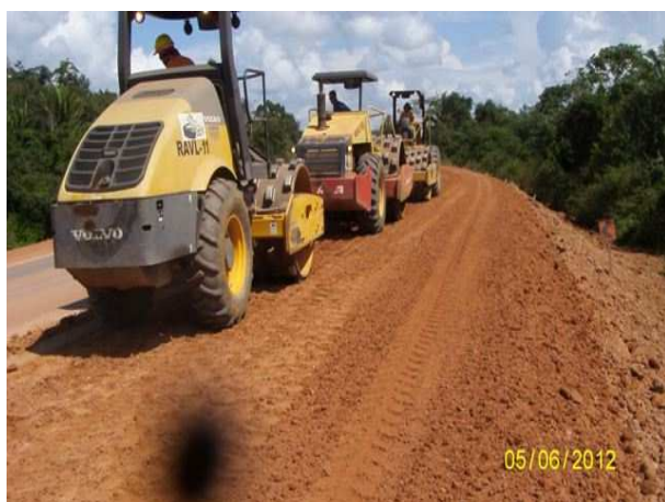
Foto 3.5 – Compactação do material de aterro
