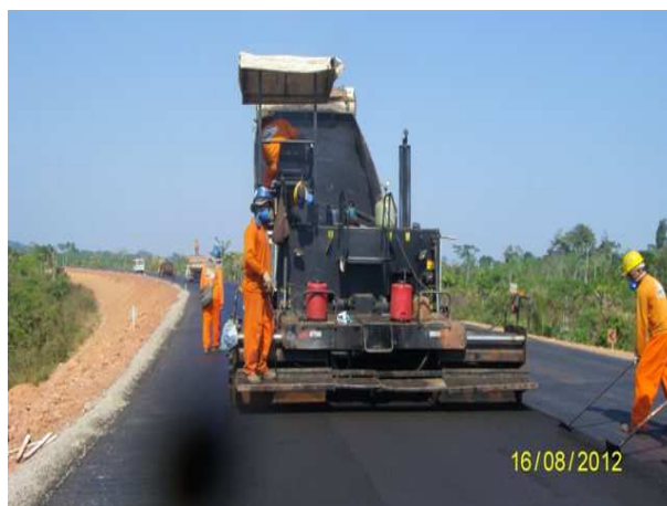
Foto 3.18 – Lançamento de CBUQ.
