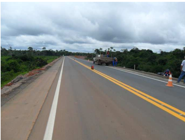
Foto 7.27 – Execução de sinalização horizontal.
