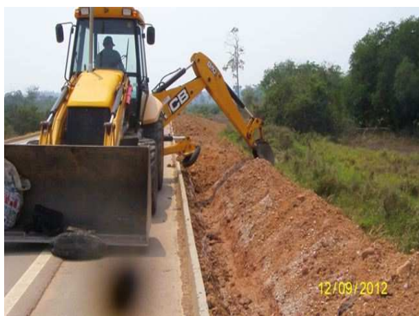
Foto 3.35 – Relocação dos cabos de fibra óptica da OI.
