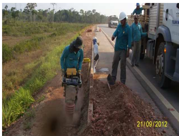
Foto 3.36 – Relocação dos cabos de fibra óptica da OI.
