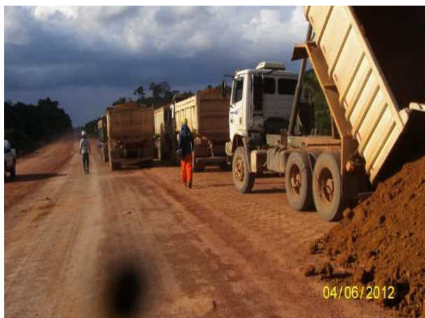
Foto 3.3 – Lançamento de material no local do aterro.
