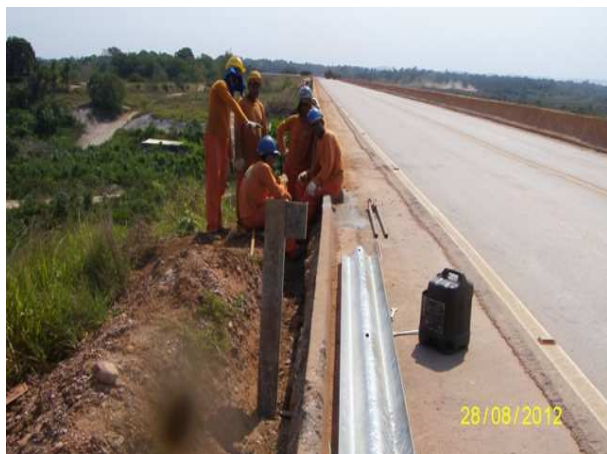
Foto 3.37 – Instalação de defensas metálica nas cabeceiras das pontes rodoviárias.
