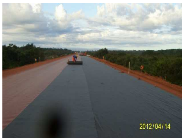
Foto 3.6 – Aplicação de manta geotêxtil.
