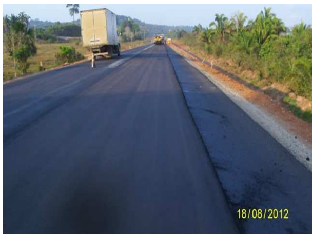
Foto 3.19 – Compactação do CBUQ.
