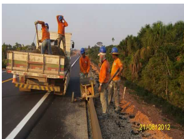
Foto 3.21 – Execução de meio fio e sarjeta.
