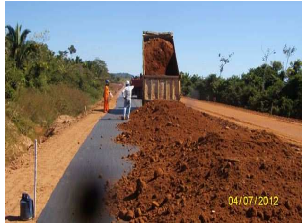
Foto 3.8 – Lançamento de material no local do aterro.
