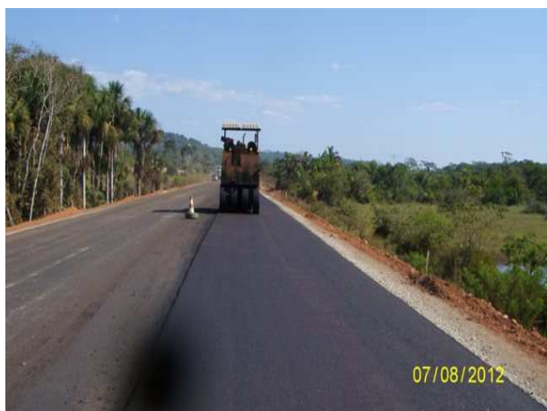
Foto 3.17 – Compactação do Binder.
