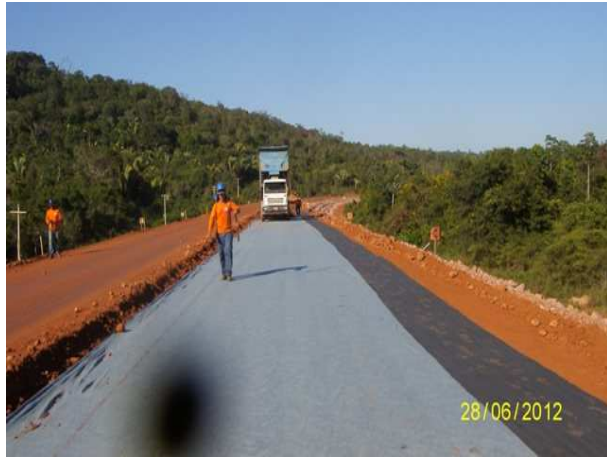
Foto 3.7 – Aplicação de manta geotêxtil.
