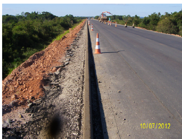
Foto 3.24 – Execução de meio fio e sarjeta.
