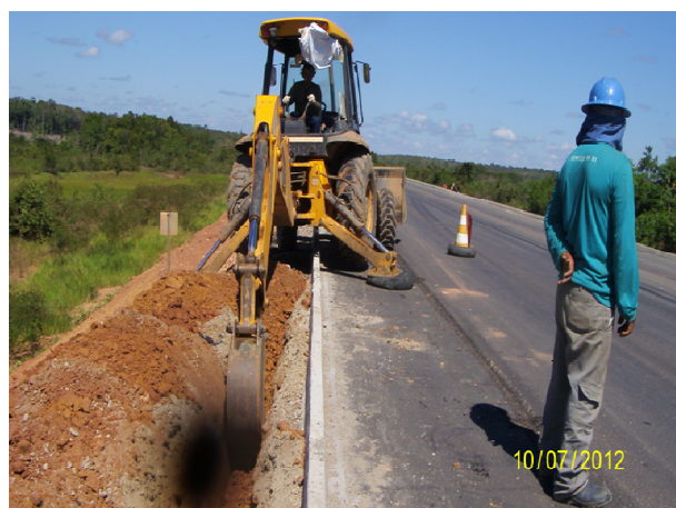
Foto 3.33 – Relocação dos cabos de fibra óptica da OI.
