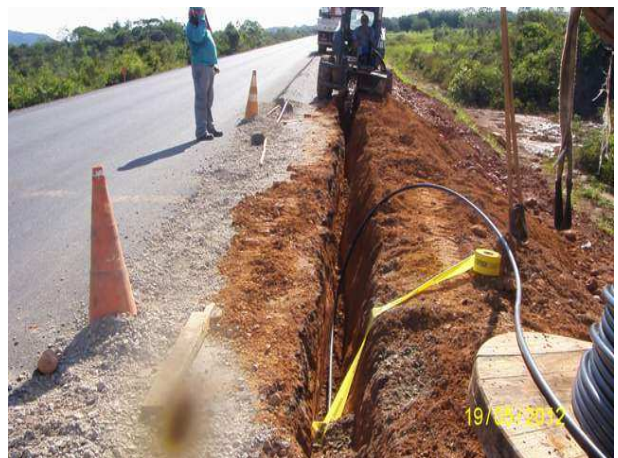
Foto 3.30 – Relocação dos cabos de fibra óptica da OI.
