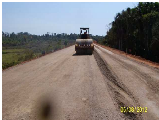
Foto 3.11 – Compactação de B.G.S.
