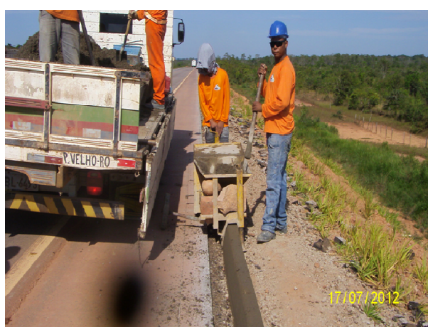
Foto 3.22 – Execução de meio fio e sarjeta.
