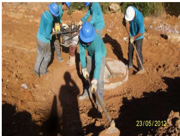
Foto 3.31 – Relocação dos cabos de fibra óptica da OI.
