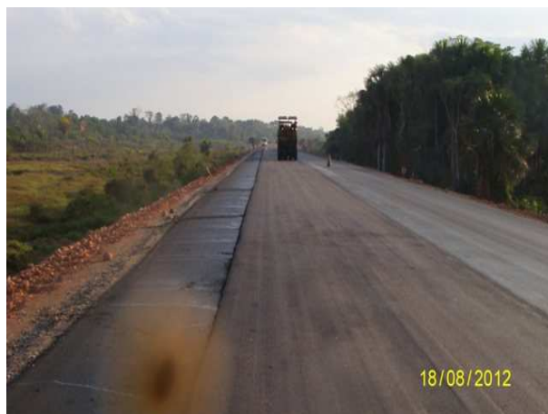
Foto 3.20 – Compactação do CBUQ.
