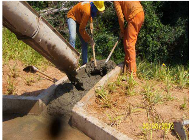
Foto 3.26 – Execução de descidas d'água.
