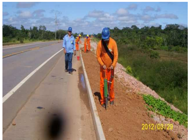
Foto 3.28 – Execução de hidrossemeadura.
