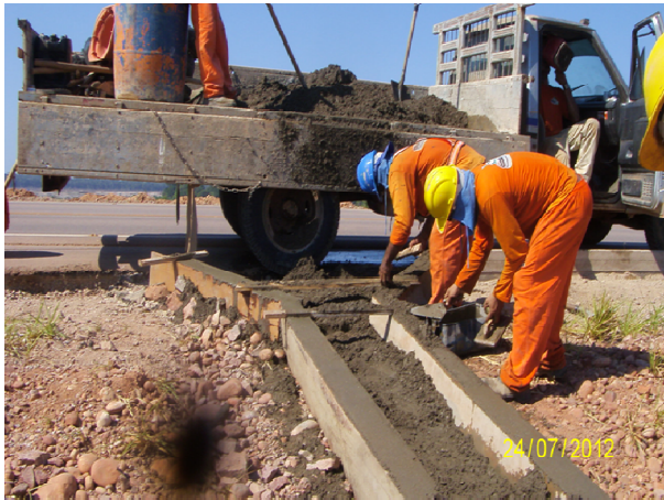
Foto 3.25 – Execução de descidas d'água.
