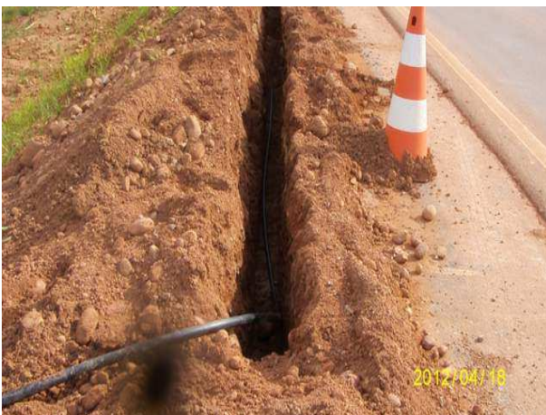
Foto 3.29 – Relocação dos cabos de fibra óptica da OI.
