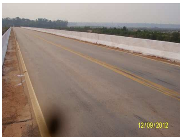
Foto 3.40 – Execução de caiação nos guarda corpos em concreto das pontes rodoviárias.
