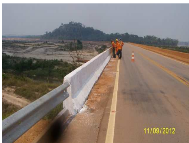
Foto 3.39 – Execução de caiação nos guarda corpos em concreto das pontes rodoviárias.
