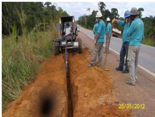
Foto 3.32 – Relocação dos cabos de fibra óptica da OI.
