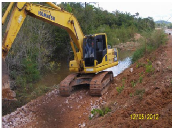
Foto 3.1 – Transporte e aplicação de rachão para preenchimento de cavas inundadas.
