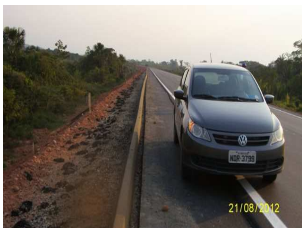
Foto 3.23 – Execução de meio fio e sarjeta.
