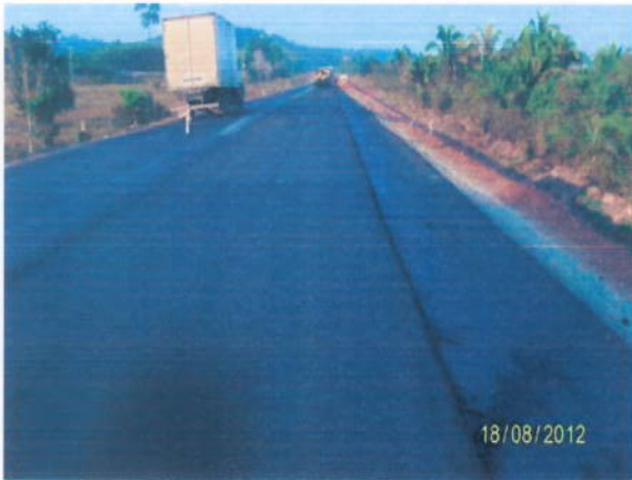
Foto 3.19 – Compactação do CBUQ.
