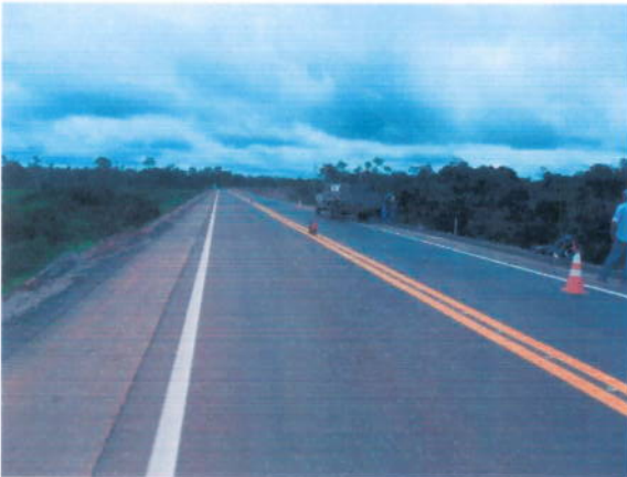
Foto 7.27 – Execução de sinalização horizontal.
