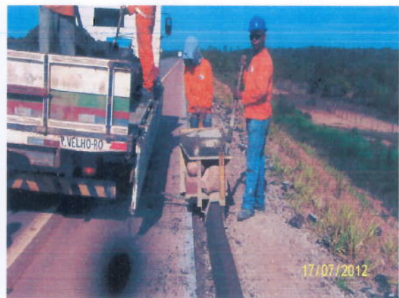
Foto 3.22 – Execução de meio fio e sarjeta.
