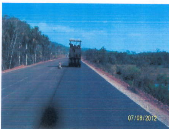
Foto 3.17 – Compactação do Binder.
