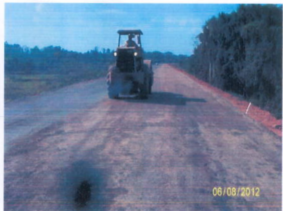
Foto 3.12 – Compactação de B.G.S.
