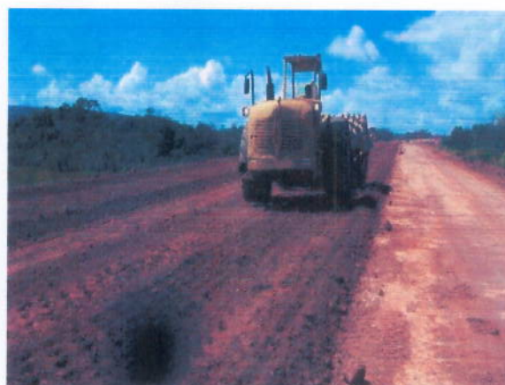
Foto 3.4 – Compactação do material de aterro
