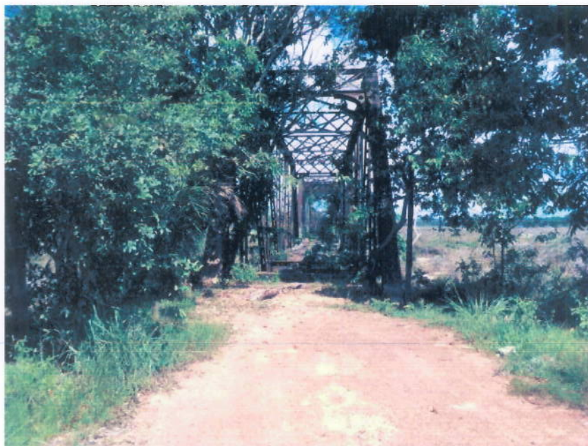
Foto 05 – Ponte Ferroviária sobre o Rio Mutum, antes das obras de alteamento.
