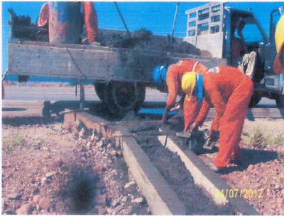
Foto 3.25 – Execução de descidas d'água.
