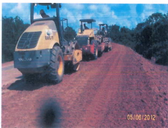
Foto 3.5 – Compactação do material de aterro
