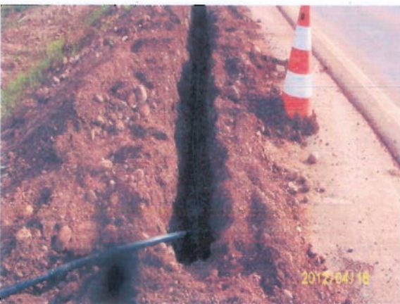
Foto 3.29 – Relocação dos cabos de fibra óptica da OI.
