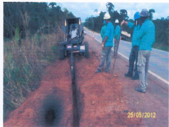
Foto 3.32 – Relocação dos cabos de fibra óptica da OI.
