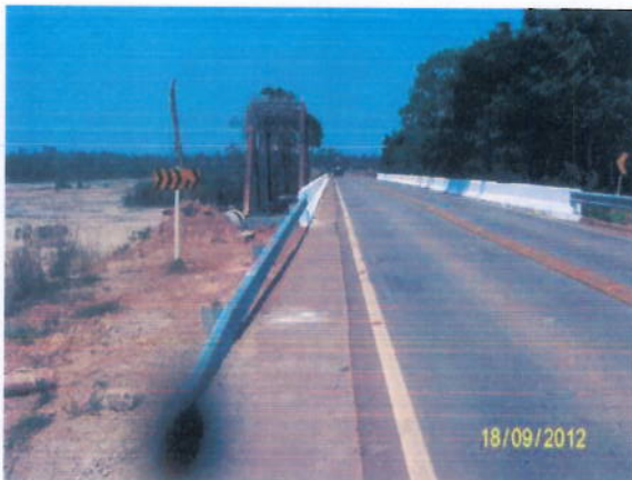
Foto 3.41 – Execução de caiação nos guarda corpos em concreto das pontes rodoviárias.
