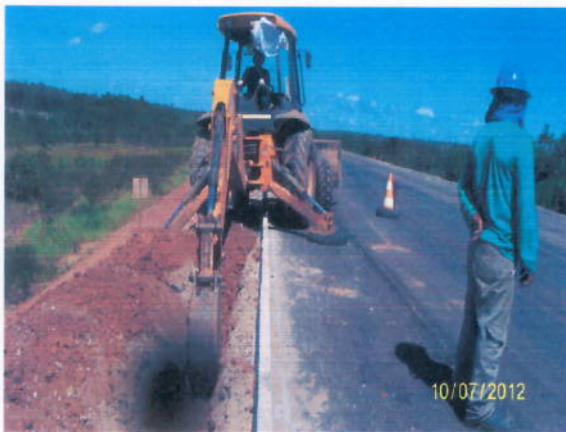
Foto 3.33 – Relocação dos cabos de fibra óptica da OI.
