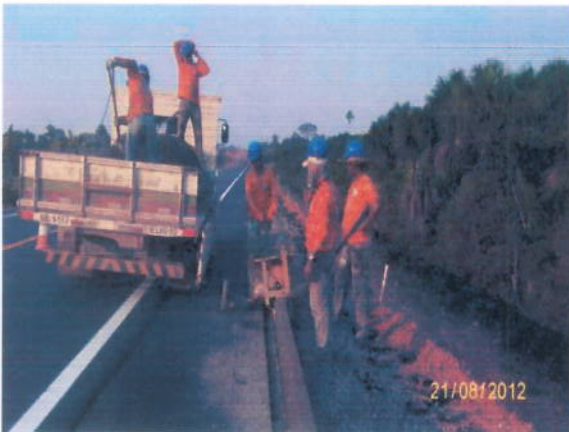
Foto 3.21 – Execução de meio fio e sarjeta.
