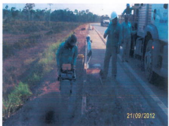
Foto 3.36 – Relocação dos cabos de fibra óptica da OI.
