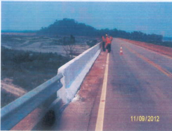
Foto 3.39 – Execução de caiação nos guarda corpos em concreto das pontes rodoviárias.
