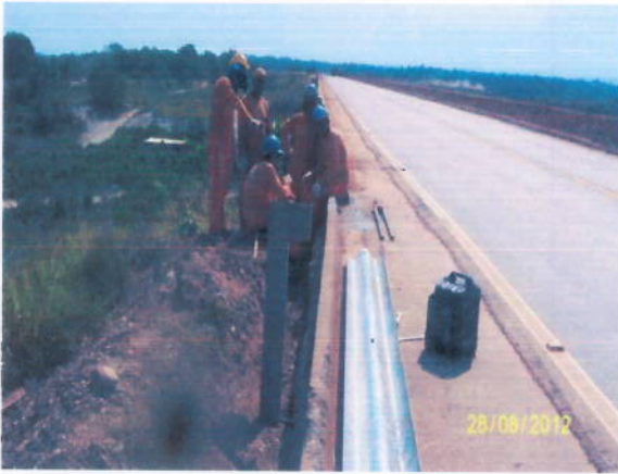
Foto 3.37 – Instalação de defensas metálica nas cabeceiras das pontes rodoviárias.
