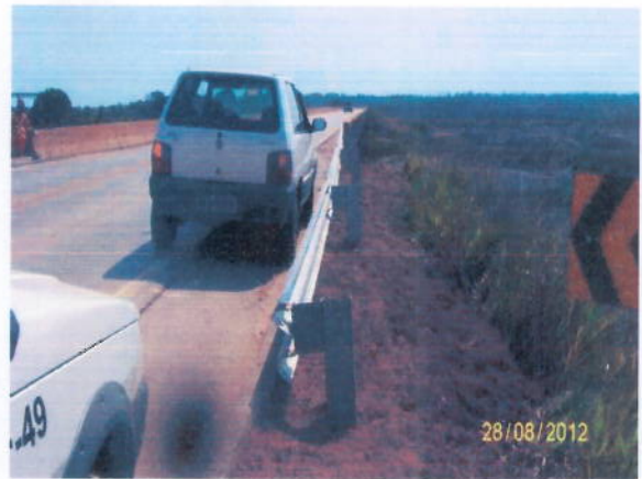
Foto 3.38 – Instalação de defensas metálica nas cabeceiras das pontes rodoviárias.
