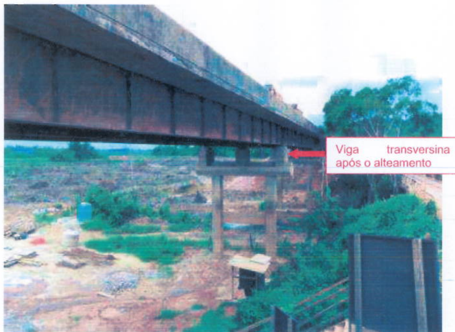
Foto 02 -- Vão Central da Ponte do Igarapé 154 já alteada.
