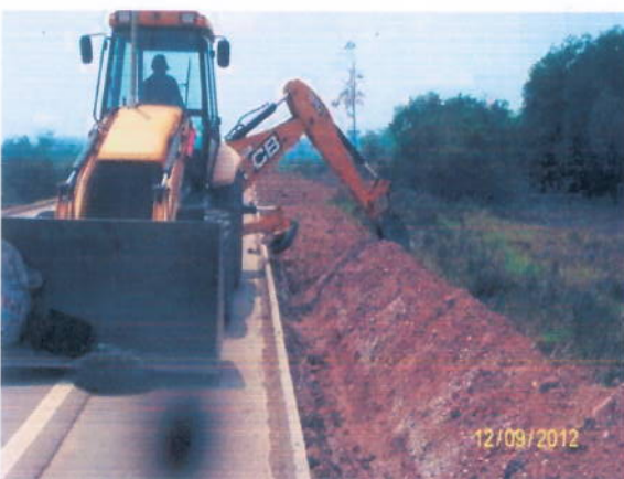
Foto 3.35 – Relocação dos cabos de fibra óptica da OI.
