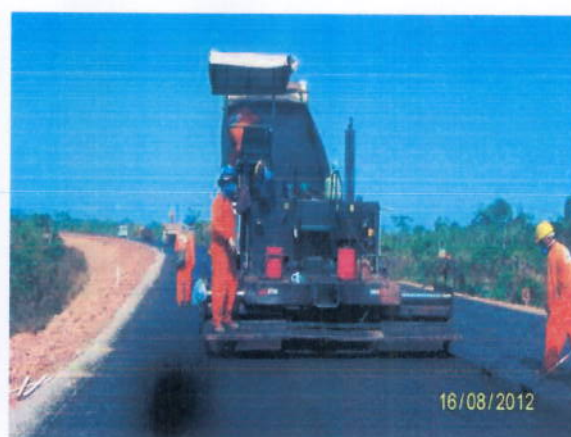
Foto 3.18 – Lançamento de CBUQ.
