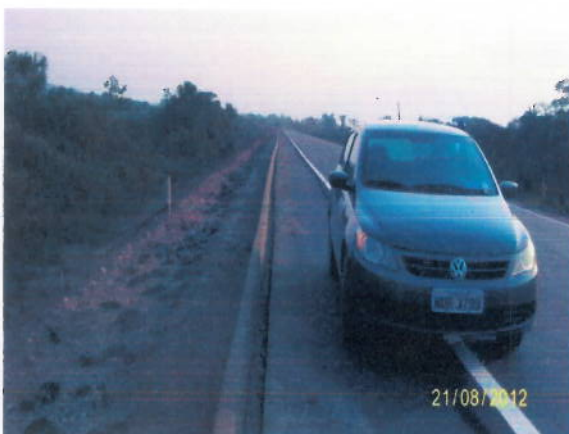
Foto 3.23 – Execução de meio fio e sarjeta.
