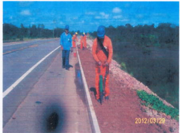
Foto 3.28 – Execução de hidrossemeadura.
