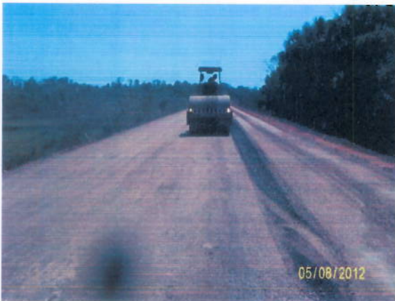
Foto 3.11 – Compactação de B.G.S.
