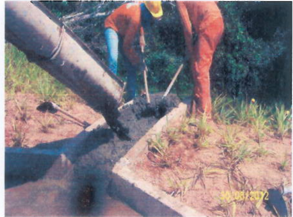
Foto 3.26 – Execução de descidas d'água.
