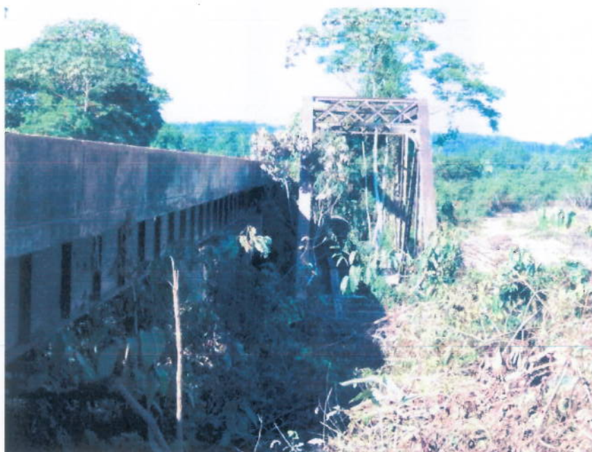
Foto 03 – Ponte Ferroviária sobre o Igarapé 162, antes das obras de alteamento.
