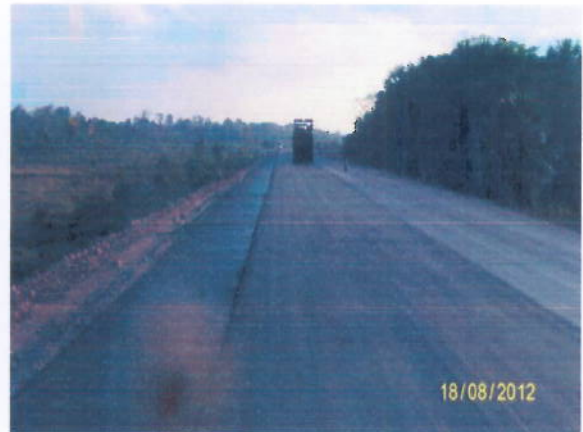
Foto 3.20 – Compactação do CBUQ.
