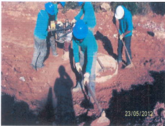
Foto 3.31 – Relocação dos cabos de fibra óptica da OI.
