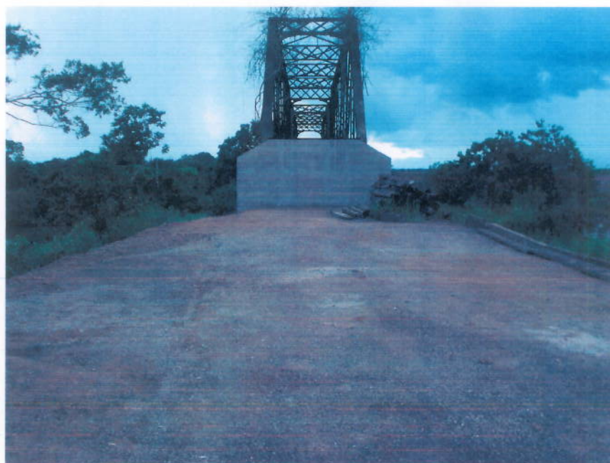
Foto 06 – Ponte Ferroviária sobre o Rio Mutum, após as obras de alteamento.
