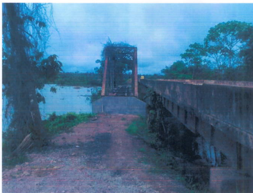
Foto 04 – Ponte Ferroviária sobre o Igarapé 162, após as obras de alteamento.
