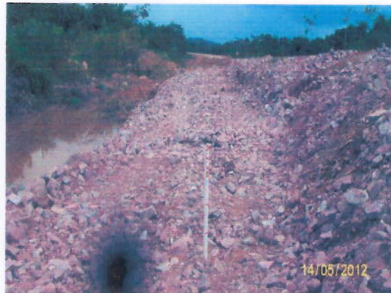
Foto 3.2 – Transporte e aplicação de rachão para preenchimento de cavas inundadas.
