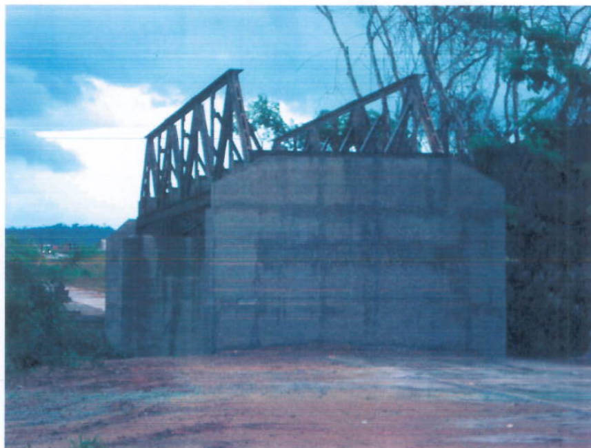
Foto 02 – Ponte Ferroviária sobre o Igarapé 154, após as obras de alteamento.
