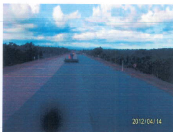
Foto 3.6 – Aplicação de manta geotêxtil.
