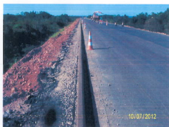
Foto 3.24 – Execução de meio fio e sarjeta.
