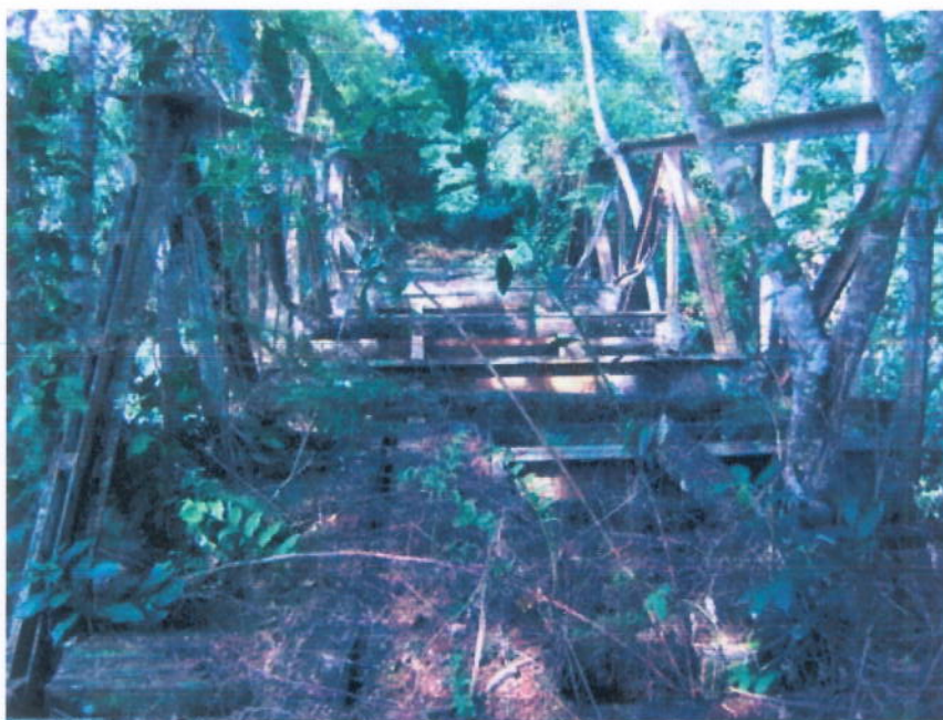
Foto 01 – Ponte Ferroviária sobre o Igarapé 154, antes das obras de alteamento.
