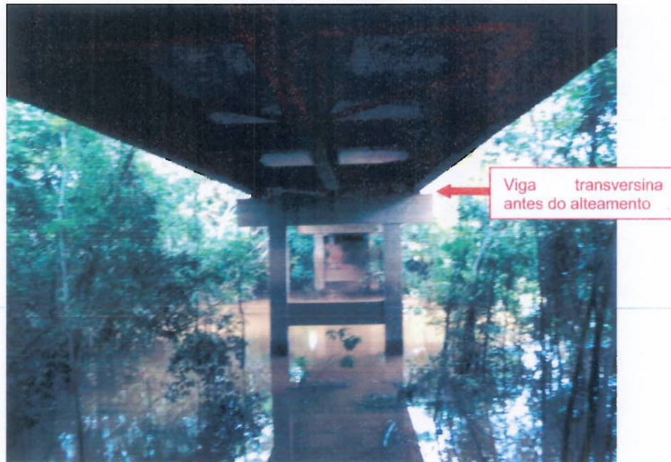
Foto 01 -- Vista do vão central da ponte rodoviária sobre o igarapé 154, antes das obras de alteamento.
