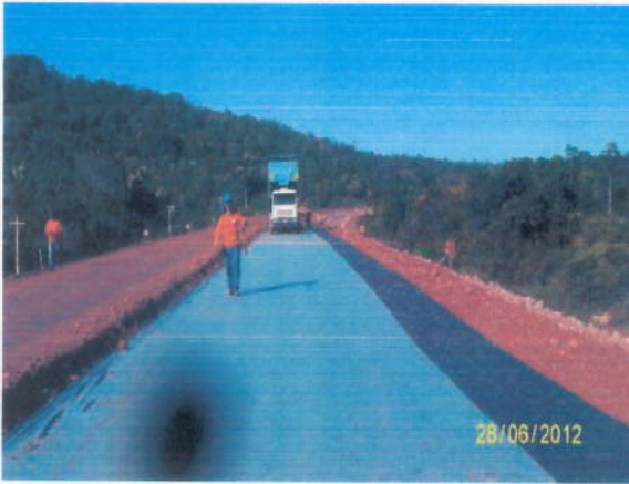
Foto 3.7 – Aplicação de manta geotêxtil.
