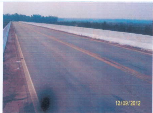
Foto 3.40 – Execução de caiação nos guarda corpos em concreto das pontes rodoviárias.
