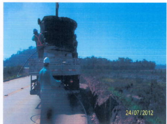
Foto 3.34 – Relocação dos cabos de fibra óptica da OI.
