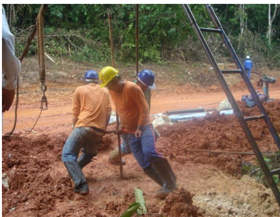
Foto 4.6.1 – Acompanhamento de sondagem (28/10/2011).
