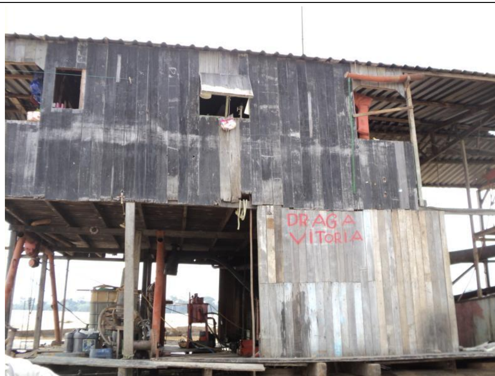
Foto 29.1 – Draga Vitória em operação. Não cadastrada.
