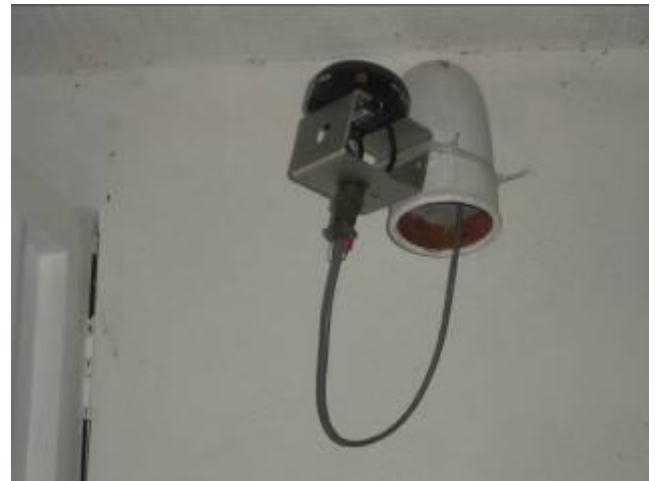
Foto 19 – Antena do GPS instalada fora da cabine, na parte superior a direita da porta (Ver Foto 8 )
