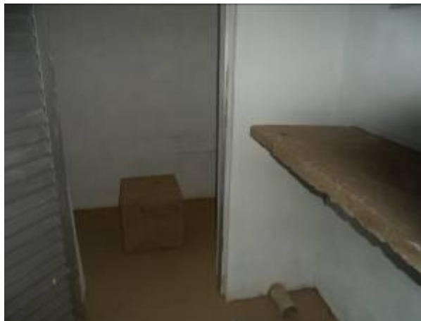
Foto 10 – Interior da Cabine mostrando a Sala do Sensor, com a sua base, no fundo, e a Sala do Registrador na frente..
