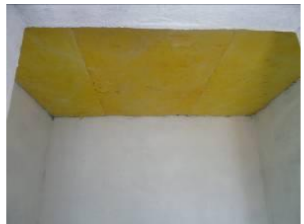
Foto 11 – Teto da Sala do Sensor mostrando a placa de lã de vidro que também isola as paredes dessa sala.
