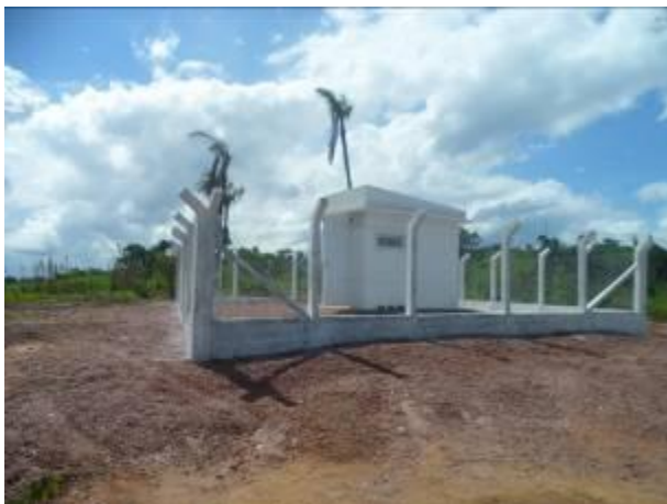
Foto 7 – Vista panorâmica da cabine que serve de abrigo para a Estação Sismográfica JIR2, construída em um afluente de arenito da Formação Palmeiral, do Proterozóico Superior (idade > 1,0 Ga).
