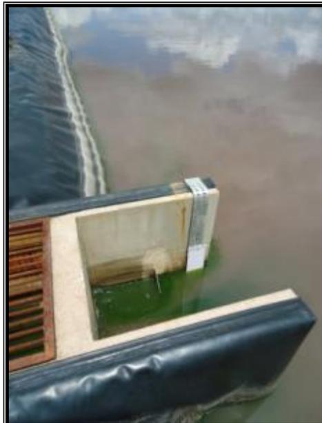
**Figura 20-** Vista do indicador de nível e da nova régua milimetrada instalada para medição de vazão na ETE 1.
