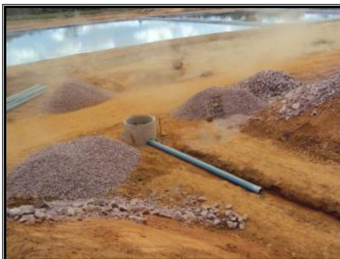
**Figura 5-** Vista da chegada do tubo coletor de chorume na caixa de passagem.
