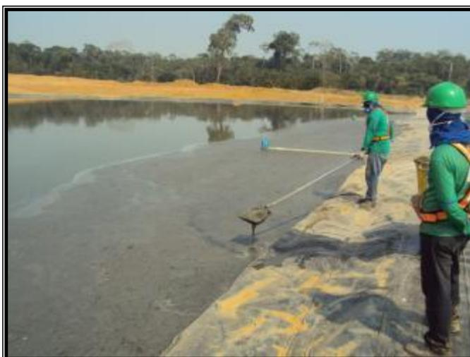
**Figura 27-** Manutenção da ETE com Remoção de sobrenadantes.
