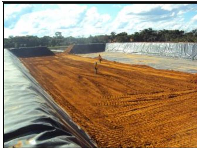
**Figura 1-** Camada de argila compactada para proteção do PEAD.
