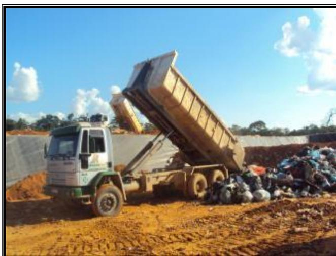
**Figura 7-** Chegada do material a ser aterrado.
