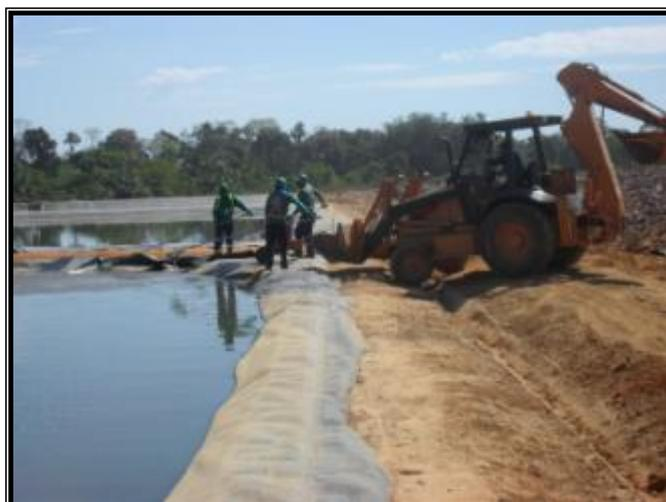
**Figura 26-** Retirada de sobrenadantes da ETE com auxílio de retro escavadeira.
