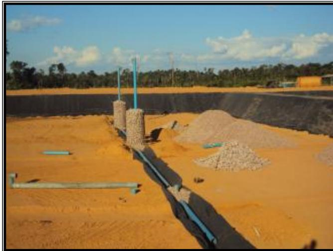
**Figura 2-** Execução da drenagem de fundação: geotêxtil + brita + tubo de dreno + brita + transpasse do geotêxtil.
