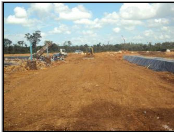
**Figura 11-** Chegada do material de cobertura composto por solo + resíduo de cimento.
