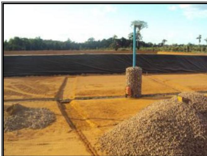
**Figura 3-** Preparação com manta PEAD para a cobertura impermeabilizada e dreno de chorume e gases da 6ª e 7ª células de resíduos.
