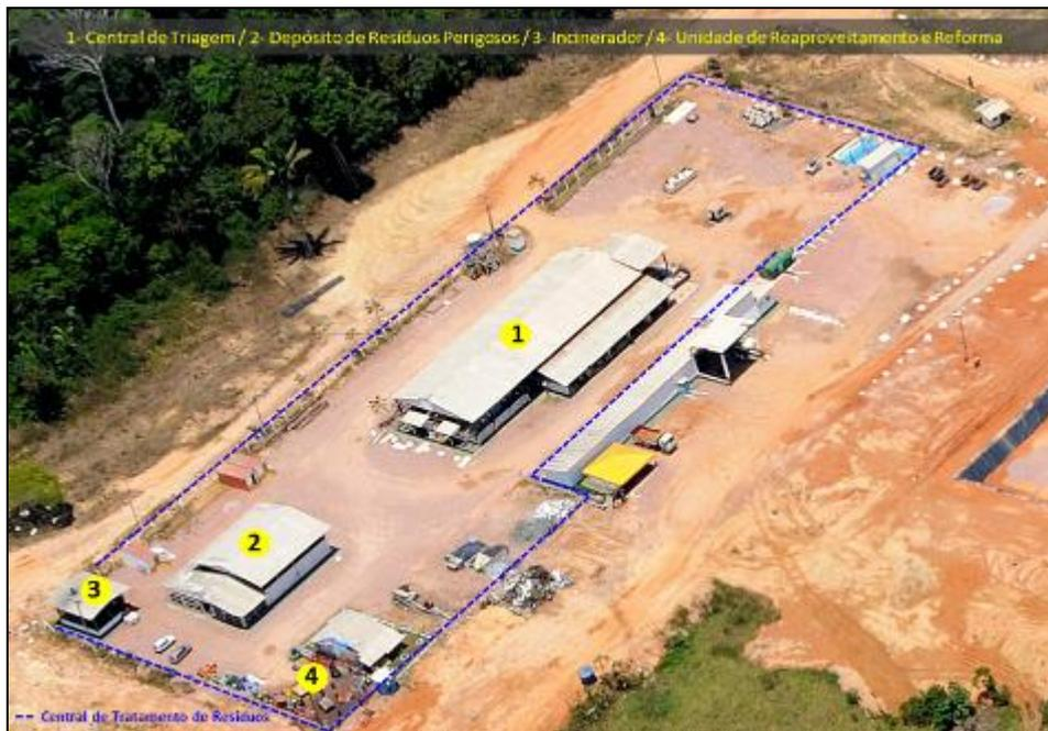
Nestas instalações encontram-se: nº. 1 – Central de Triagem e Tratamento de Resíduos; nº. 2 – Depósito de Armazenamento de Sólidos Contaminados; nº. 3 – Incinerador de Resíduos Perigosos; e, nº. 4 – Rampa de Lavagem, um sistema completo de processamento de resíduos.
