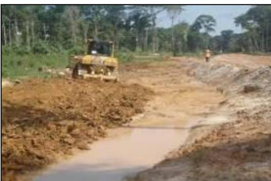
Foto 45: Preparação do terreno (descompactação).
