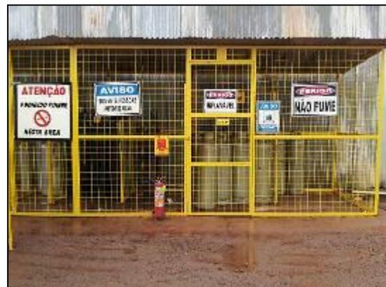
Foto 120: Armazenamento de gases comprimidos.
