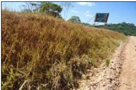
Foto 47: Taludes com proteção vegetal.
