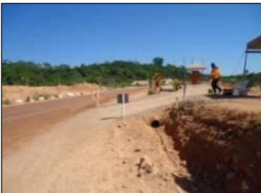
Foto 37: Direcionamento das águas nas vias.
