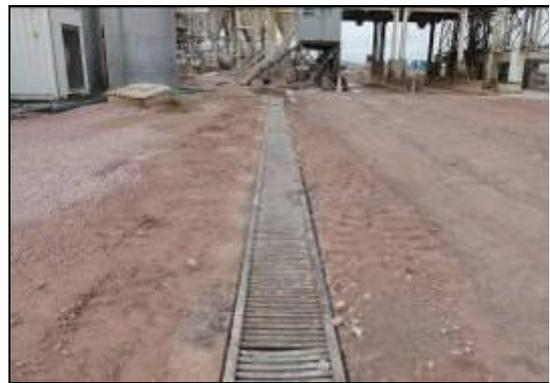
Foto 10: Sistema de drenagem de efluentes.
