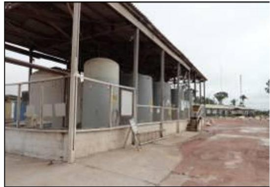
Foto 12: Detalhe da contenção do depósito.
