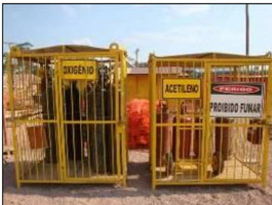
Foto 119: Armazenamento de gases comprimidos.
