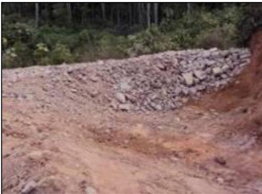
Foto 35: Bacias de sedimentação e filtração.
