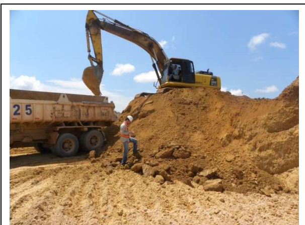
Figura 06 – Área de empréstimo 3 (jusante) - margem direita (22/10/2010)
