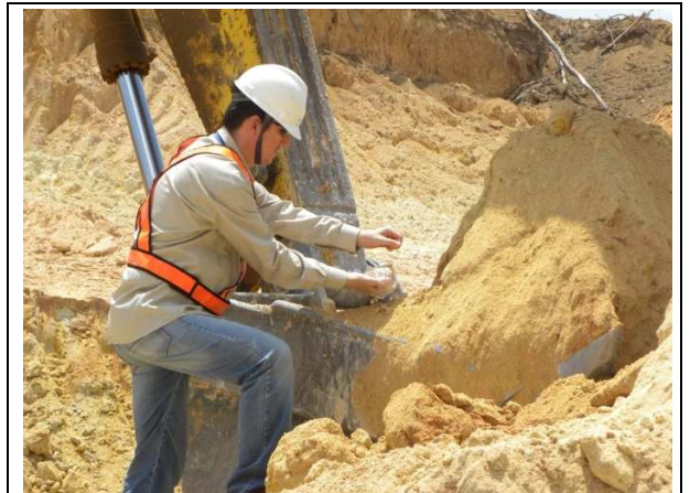
Figura 05 – Área de empréstimo 4 (jusante) - margem direita (22/10/2010)
