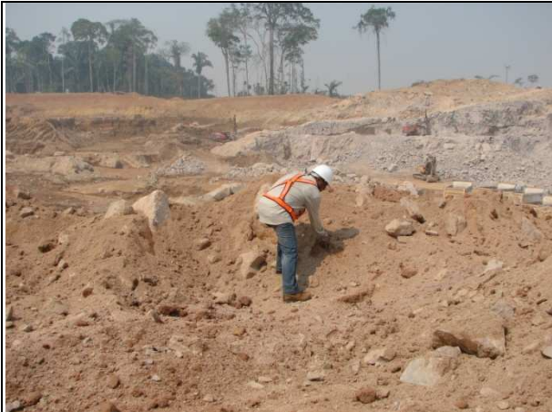
Figura 02 – Canal de fuga do AHE Jirau - margem esquerda (10/09/2010)
