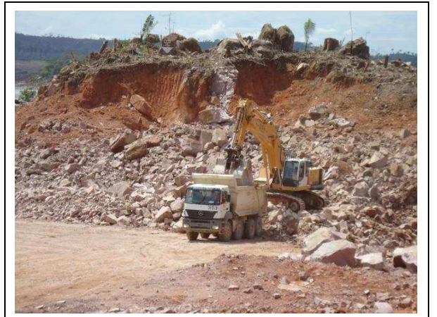
Figura 11 – Canal de fuga – margem esquerda (24/11/2010)
