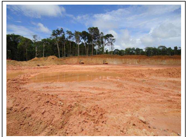
Figura 13 – Área de empréstimo – margem esquerda (24/11/2010)
