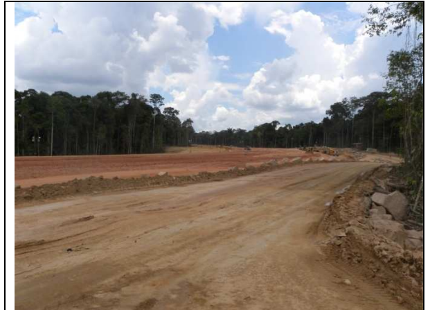
Figura 09 – Barragem de terra – margem esquerda (22/10/2010)
