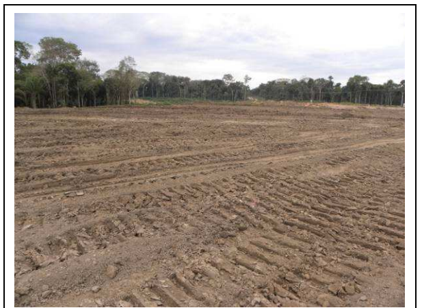
Figura 15 – Depósito de Solo Orgânico – Margem Direita (16/07/2010)
