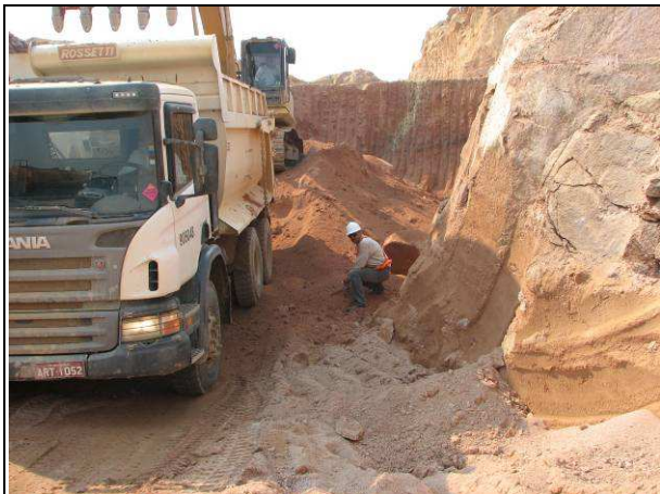
Figura 16 – Vertedouro – Ilha Pequena (18/08/2010)
