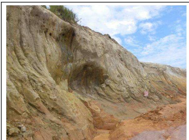
Figura 14 – Eixo da Barragem do AHE Jirau – Margem Direita (16/07/2010)
