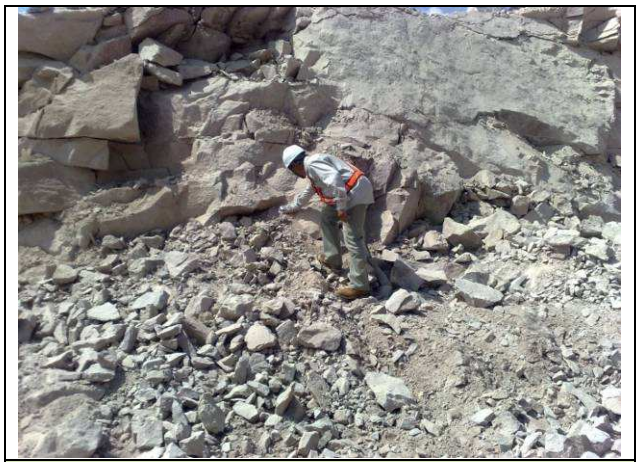
Figura 05 – Área da Casa de Força 1 - Ilha Pequena (21/06/2010)
