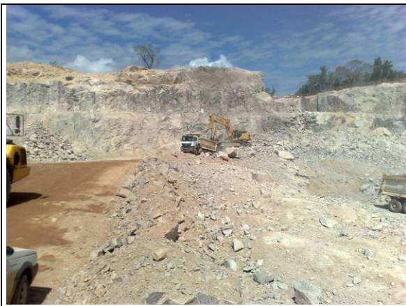
Figura 04 – Área da Casa de Força 1 - Ilha Pequena (21/06/2010)
