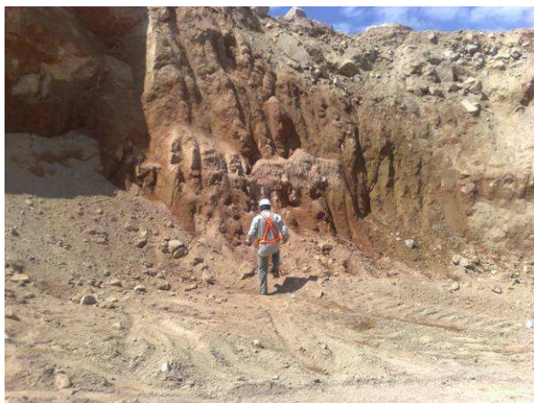
Figura 02 – Canal de Fuga do AHE Jirau - Ilha Pequena (21/06/2010)
