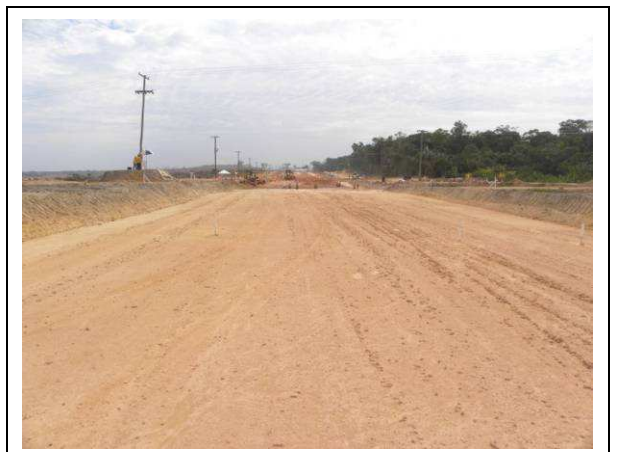
Figura 09 – Eixo da Barragem de Terra - Margem Direita (16/07/2010)
