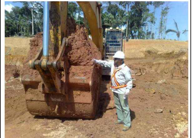
Figura 03 – Canal de Fuga do AHE Jirau - Ilha Pequena (21/06/2010)
