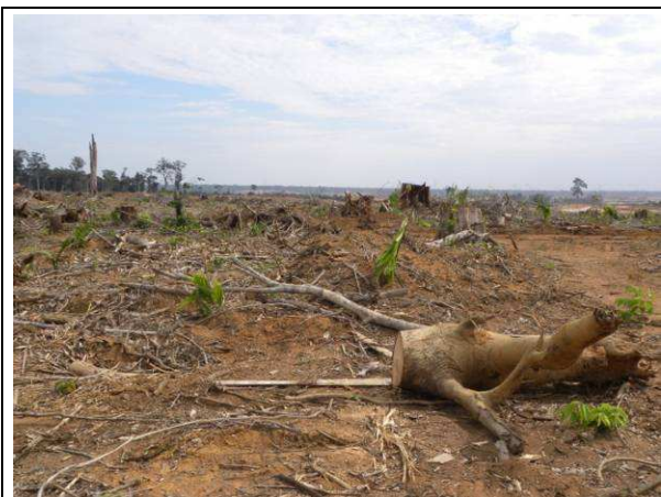
Figura 08 – Área de Supressão de Vegetação no Canteiro de Obras - Margem Direita (16/07/2010)
