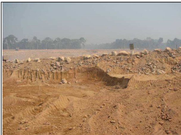
Figura 18 – Casa de Força 2 – Margem Esquerda (18/08/2010)
