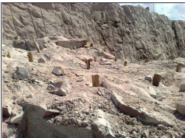
Figura 20 – Casa de Força 2 – Margem Esquerda (18/08/2010)
