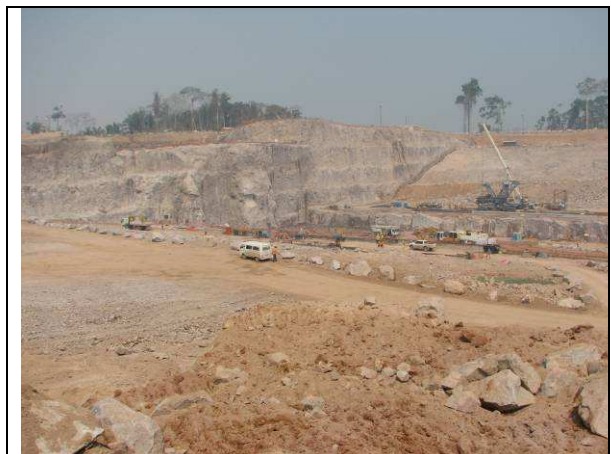
Figura 19 – Casa de Força 2 – Margem Esquerda (18/08/2010)
