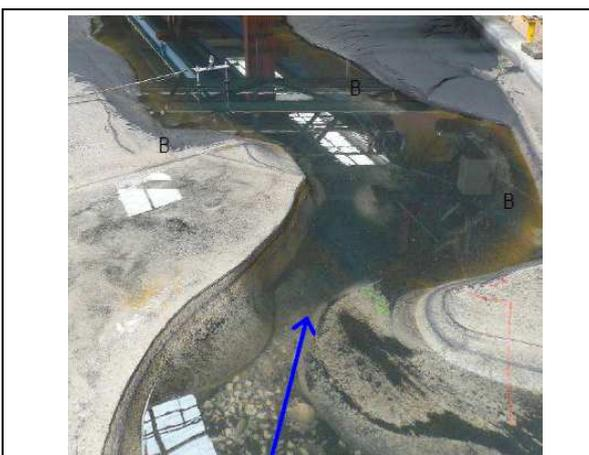
Foto 6.20 – Detalhe da deposição de sedimento junto a margem direita
