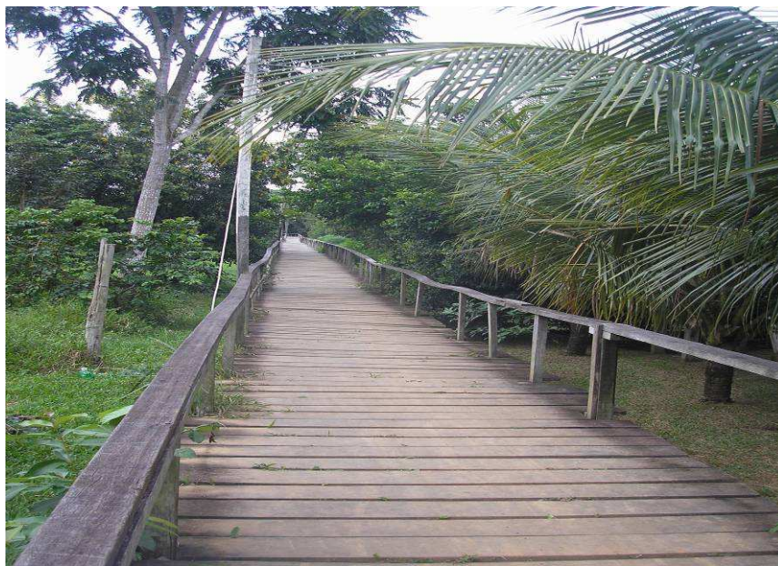
Figura 1 Ponte que faz a ligação do centro do Distrito de Calama ao Bairro São Francisco
