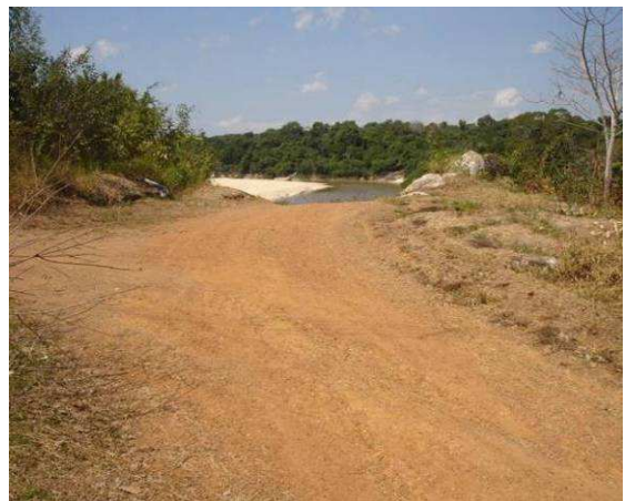
Foto 120 -- Rua Tancredo Neves e Rua da Beira, para as quais está previsto calçamento de bloquetes
