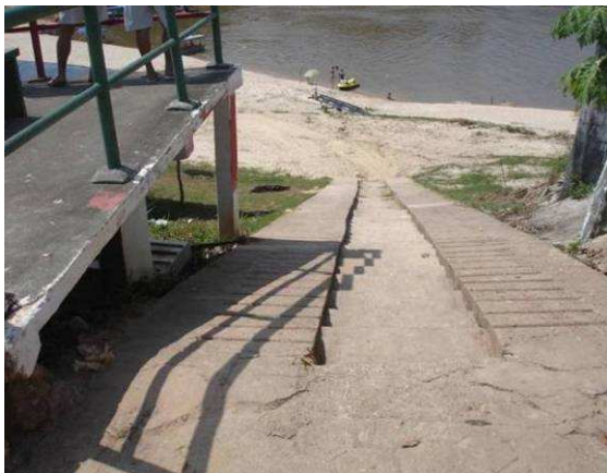
Foto 117 - Rampa para desembarque de embarcações, que a Prefeitura considera substituir
