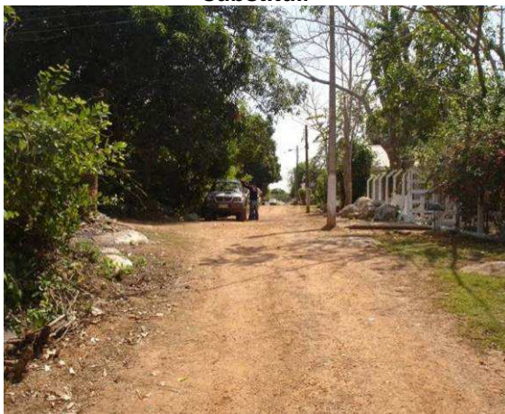
Foto 119 - Rua Tancredo Neves e Rua da Beira, para as quais está previsto calçamento de bloquetes
