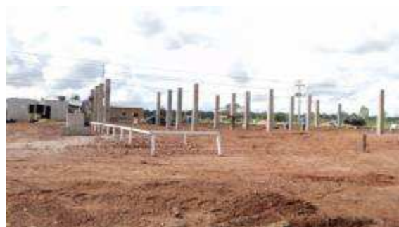
Foto 56 - Obras da Unidade de Saúde de Nova-Mutum Paraná – 27/10/2010
