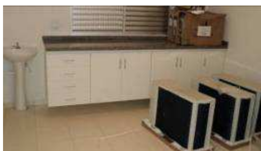
Foto 48 - Sala de imunização, detalhes da bancada com armários, lavatório e equipamentos para serem instalados.
