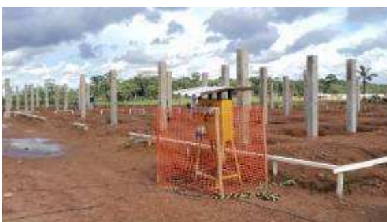
Foto 57 - Obras da Unidade de Saúde de Nova-Mutum Paraná – 27/10/2010
