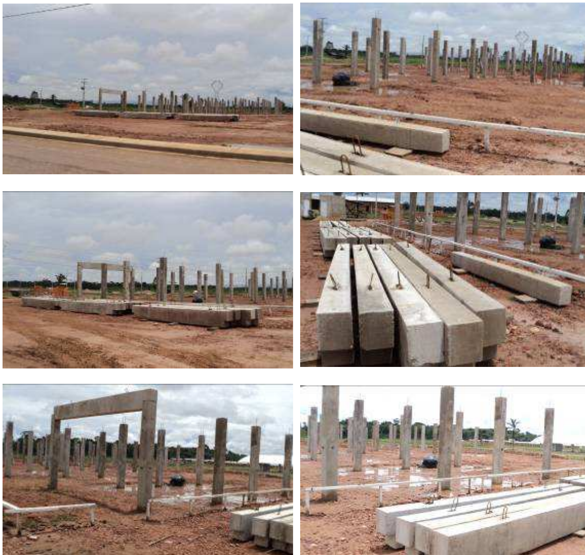
Foto 59 - Obras da Unidade de Saúde de Nova-Mutum Paraná – 25/11/10
