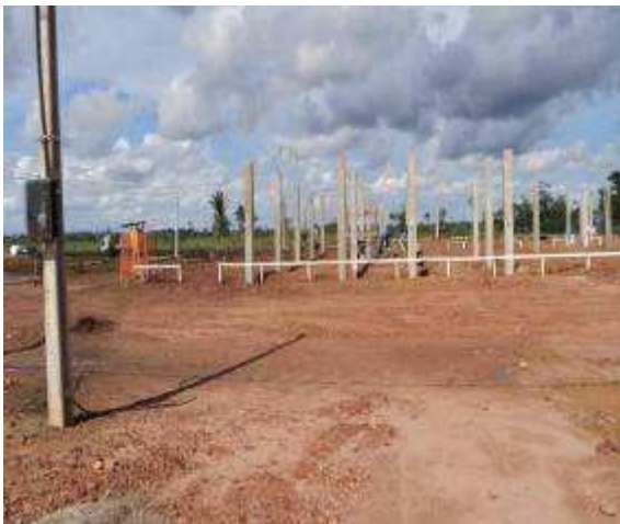
Foto 53 - Obras da Unidade de Saúde de Nova-Mutum Paraná – 27/10/2010
