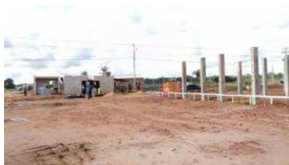
Foto 58 - Obras da Unidade de Saúde de Nova-Mutum Paraná – 27/10/2010
