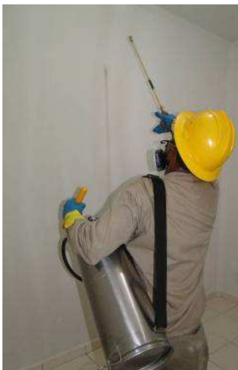
Foto 24 - Detalhe da borrifação
