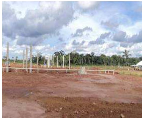
Foto 54 - Obras da Unidade de Saúde de Nova-Mutum Paraná – 27/10/2010
