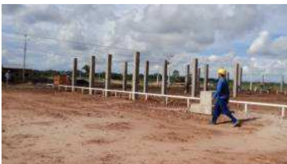
Foto 55 - Obras da Unidade de Saúde de Nova-Mutum Paraná – 27/10/2010
