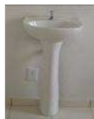
Foto 45 - Consultório clínico, detalhe do lavatório
