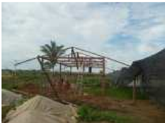
Foto 15: Esterqueira – em Construção
