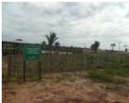
Foto 16: Cerca da Horta – Concluída
