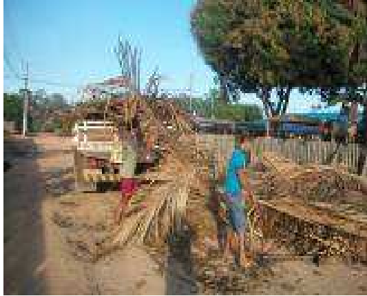
Foto 1: Retirada de Entulho
