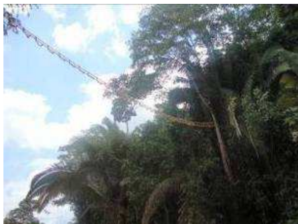
Foto 62 – Passagem dos Primatas
