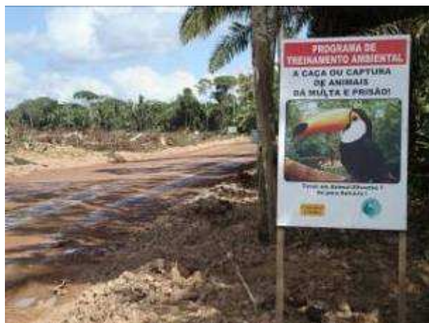
Foto 64 – Acesso da Obra
