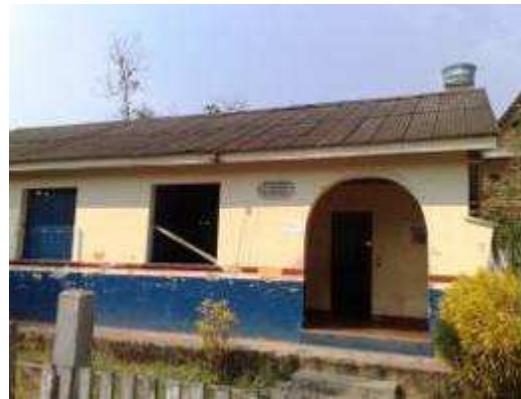
Foto 21 - EMEF Barão do Rio Branco, fachada
