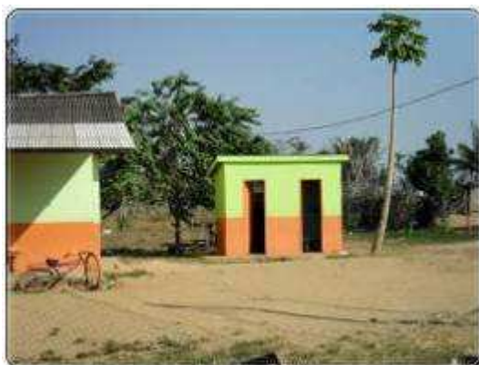
Foto 51 - EMEF Santa Júlia, sanitários
