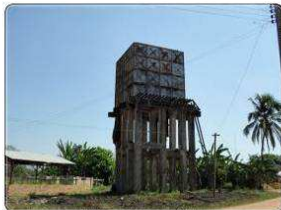
Foto 70 - Caixa de Água da EFMM
