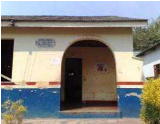
Foto 22 - EMEF Barão do Rio Branco, fachada
