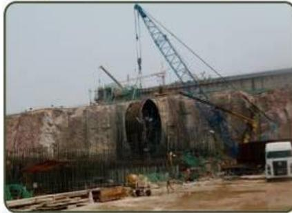
acelerado. Já finalizadas as instalações das virolas e do anel de ancoragem na unidade geradora 27, na Casa de Força I, na margem direita do rio Madeira. Para a instalação da virola, que pesa 22 toneladas, foi preciso utilizar um guindaste com capacidade para suportar 140 toneladas.
