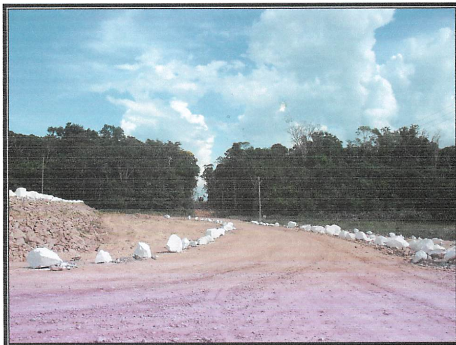
Figura 18- Via de acesso ao aterro sanitário aterro sanitário.
