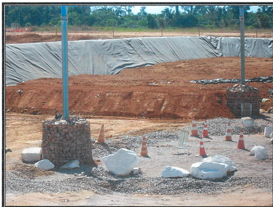
Figura 13- Vista da célula de resíduos após cobertura diária.
