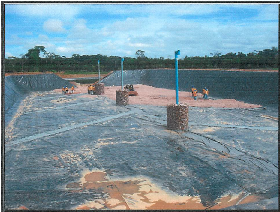
Figura 5- Drenos verticais e horizontais interligados.
