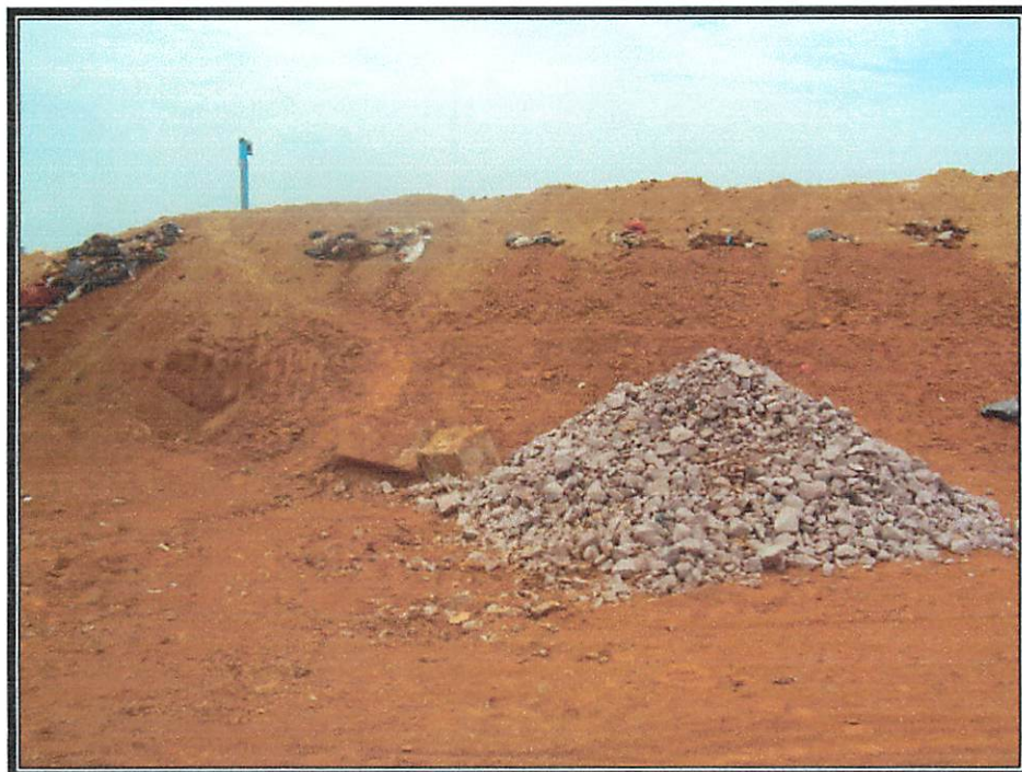
Figura 16- Uso de material britado para manutenção da drenagem e auxiliar o escoamento do chorume dentro da célula de resíduos.
