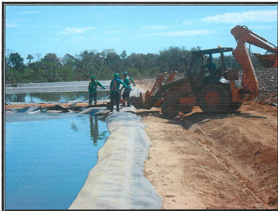
Figura 29. Retirada de sobrenadantes da ETE com auxílio de retro escavadeira.
