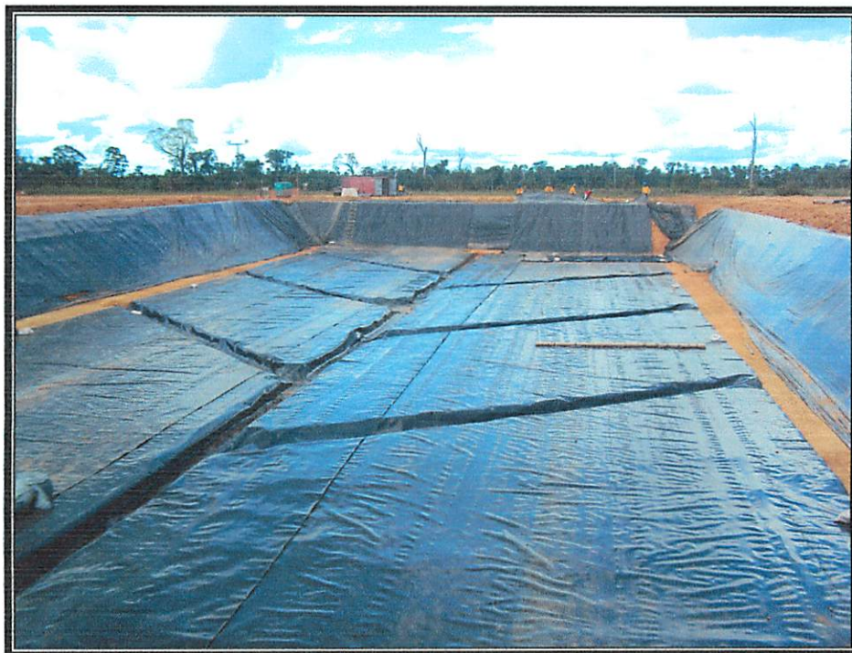
Figura 2- Cobertura impermeabilizada com PEAD em cada célula de resíduos.
