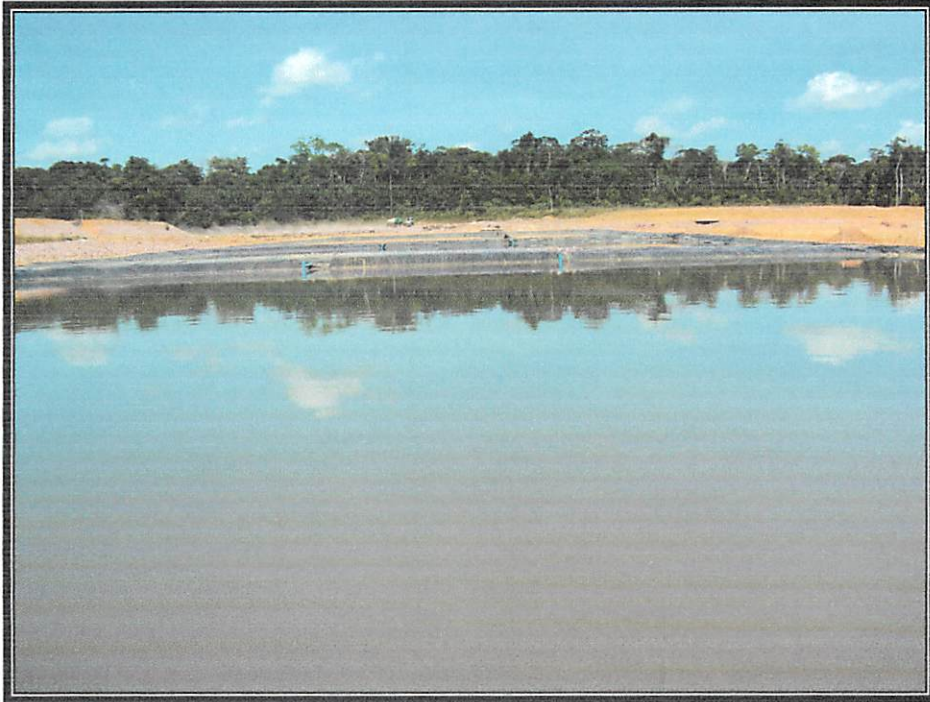
Figura 20- Estação de Tratamento de Efluentes.
