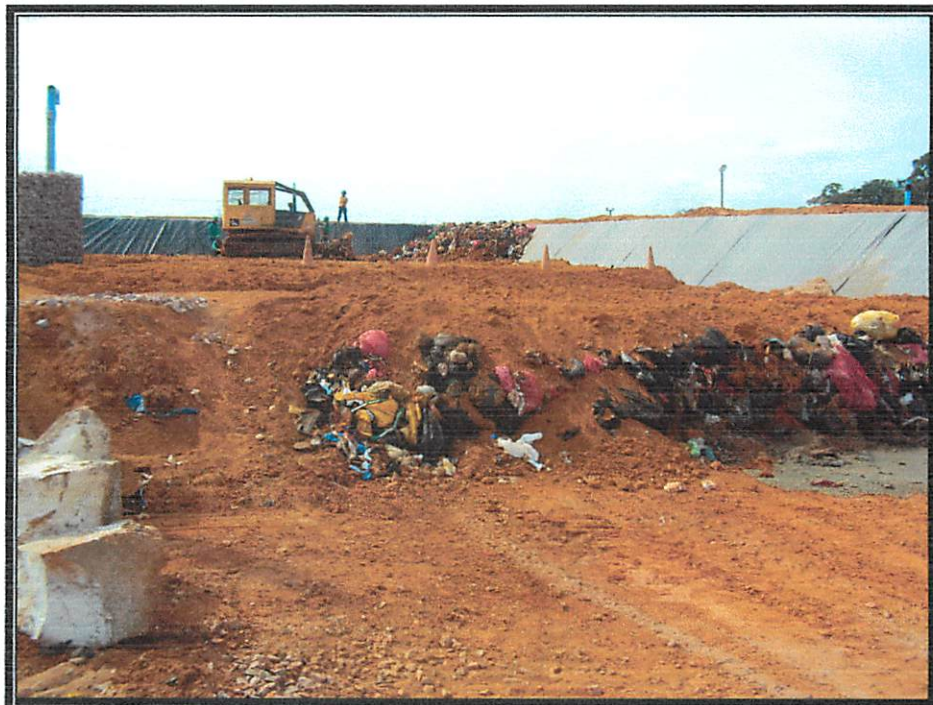
Figura 11- Material já compactado aguardando cobertura.
