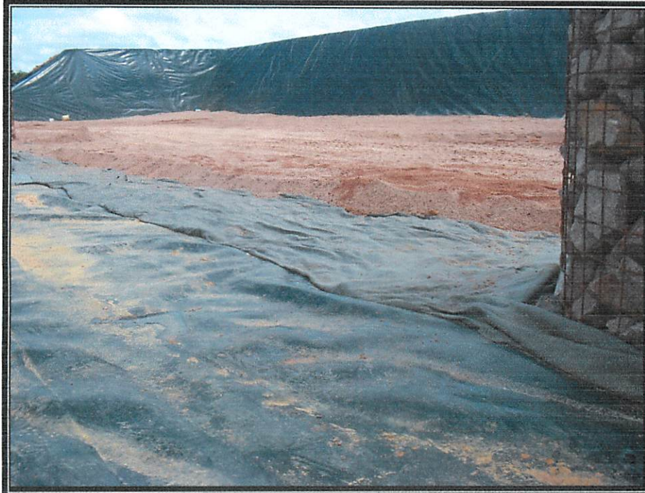
Figura 6- Camada de argila compactada para proteção do PEAD.
