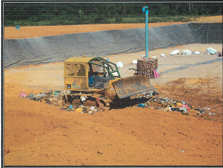
Figura 10- Espalhamento e compactação dos resíduos.
