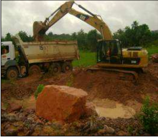
Imagem 18 – Manutenção das drenagens existentes
