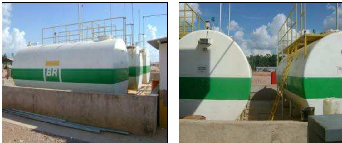
Imagem 56 – Tanques confinados
