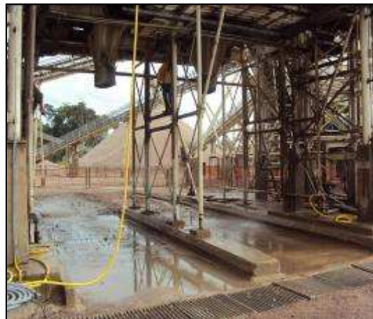
Imagem 01 – Drenagem na área de descarga de concreto
