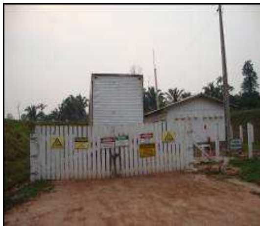
Imagem 62 – Paiol de explosivos
