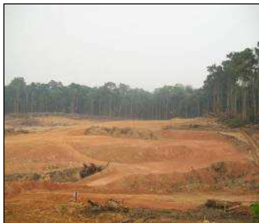
Imagem 15 – Remoção da camada vegetal do solo para posterior utilização
