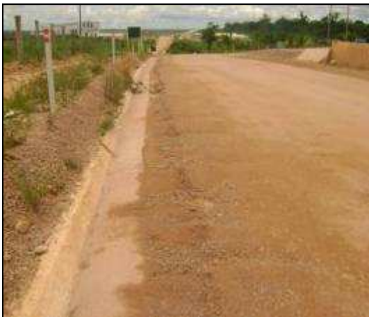
Imagem 31 – Drenagem definitiva em concreto
