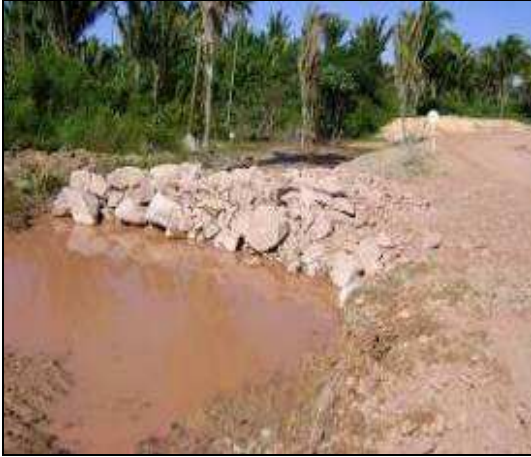
Imagem 30 – Drenagem provisórias (bacias sedimentação)
