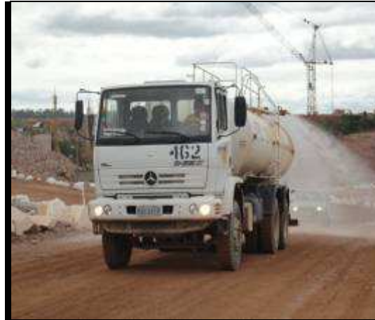
Imagem 45 – Umectação de vias de acesso no Canteiro de Obras
