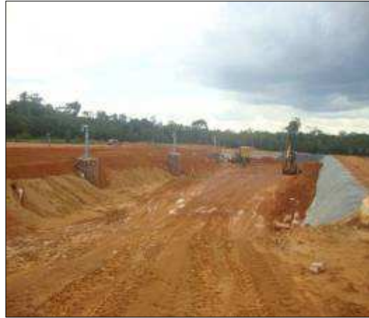
Imagem 39 – Aterro Sanitário do Canteiro de Obras
