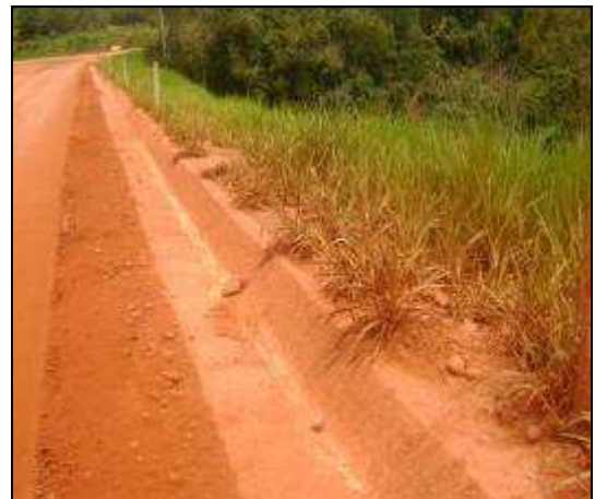
Imagem 31 – Drenagem definitiva em concreto
