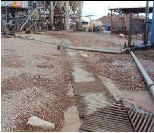
Imagem 02 – Canaletas de escoamento de efluentes líquidos
