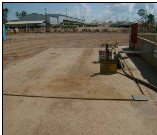
Imagem 58 – Canaletas de escoamento
