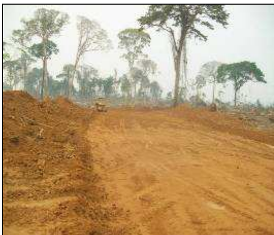
Imagem 15 – Remoção da camada vegetal do solo para posterior utilização
