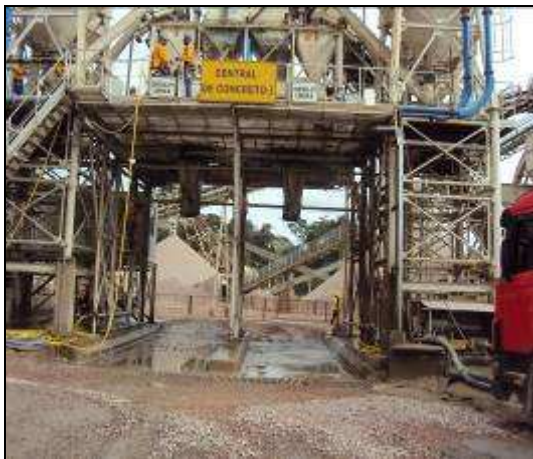
Imagem 01 – Drenagem na área de descarga de concreto
