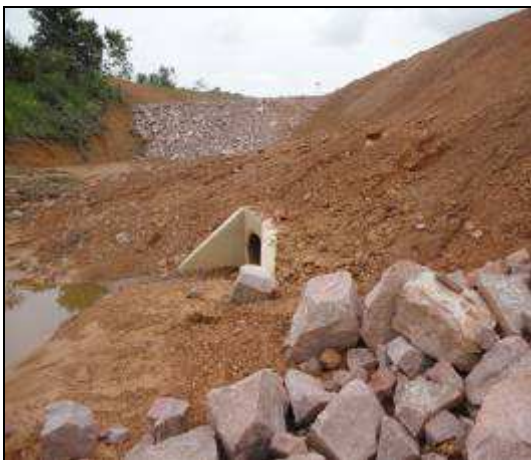
Imagem 17 – Drenagem nos acessos em execução
