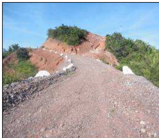
Imagem 16 – Contenção e direcionamento de águas pluviais cascalheira 02
