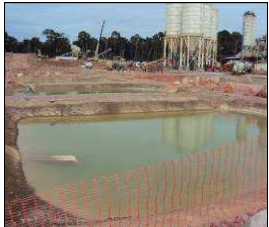
Imagem 03 – Sistema de tratamento de efluentes líquidos
