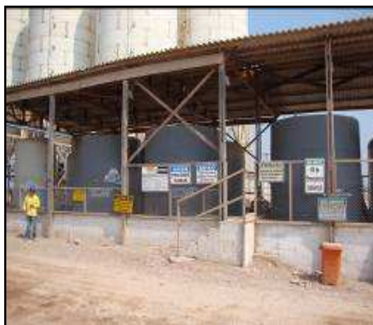
Imagem 64 – Depósito de armazenamento de aditivos
