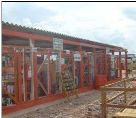
Imagem 54 – Depósito de produtos químicos
