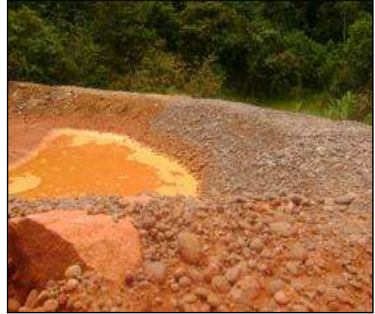
Imagem 30 – Drenagem provisórias (bacias sedimentação)
