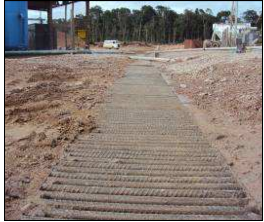
Imagem 02 – Canaletas de escoamento de efluentes líquidos
