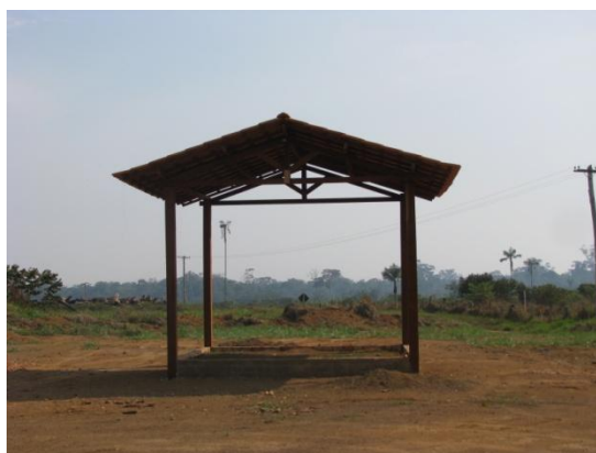
Figura 5. Vista geral da construção do depósito de combustível.
